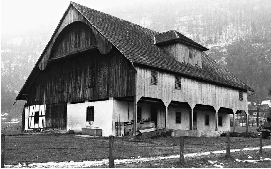
Stallscheune von 1885 mit gemauertem Stallgeschoss und Heuraum in verbretterter Gerüstbauweise. Querhoch-einfahrt und Stallvorlaube. Arth (SZ), Chronenhof (Foto: Benno Furrer, 1986).
