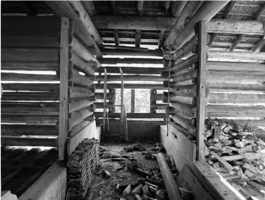
Rundholzblockbau. Heu- lagerräume und dazwischen liegende Dreschteme in einer Stallscheune bei Con- ters, Unter Cafrida (Foto: Benno Furrer, 2010).
