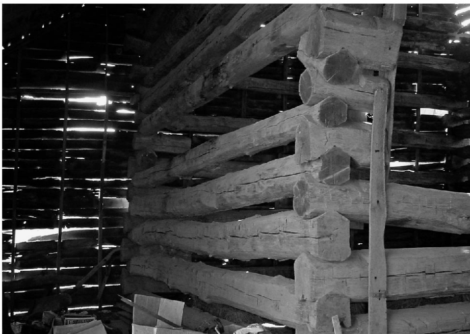
Blockbautechnik mit V-förmig zugeschnittener Verschränkung, eine eher skandinavische als alpine Zimmermannskunst. Folly Mills Creek, Arbor Hill (Virginia) (aus: http://bunnyvista.wordpress.com/2009/05/ ).
