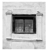
bild noch bis gegen Mitte des 20. Jahrhunderts durch die einheimische Konstruktionsart mit gemauertem Sockel- und Küchenteil und darüber errichtetem, sichtbarem Strick geprägt. Weitere auf der historischen Fotografie erkennbare Details sind zwei unregelmässig geformte, übereinander angeordnete Öffnungen an der Stelle des heutigen Fensters oberhalb des zugemauerten Kapelleneingangs.
