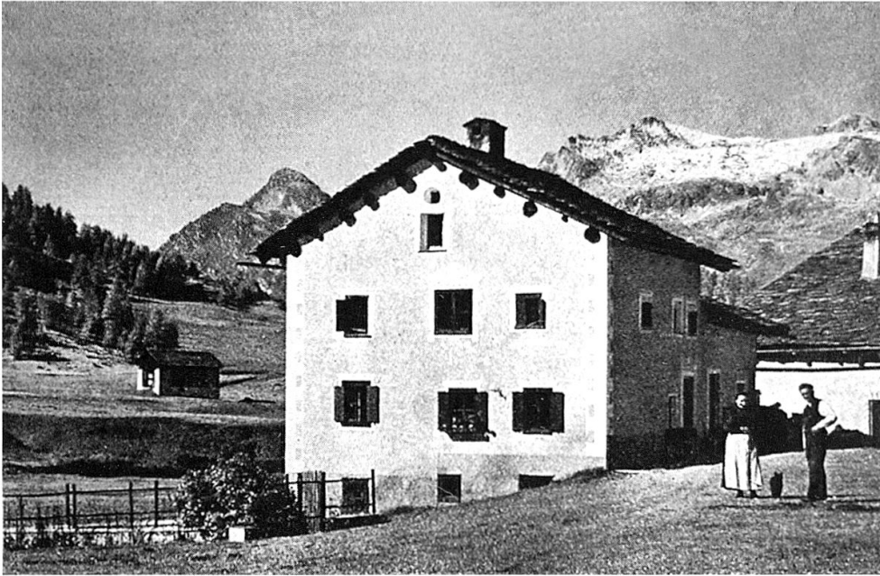
Das Pachtgut Chesa Nova, Christian Kluckers Geburtshaus und Wohnsitz in Fex Platta, kann heute als Ferienhaus gemietet werden. Die Besitzerfamilie pflegt das Andenken an den grossen Bergführer mit Sorgfalt (Foto Jean Gaberell).
