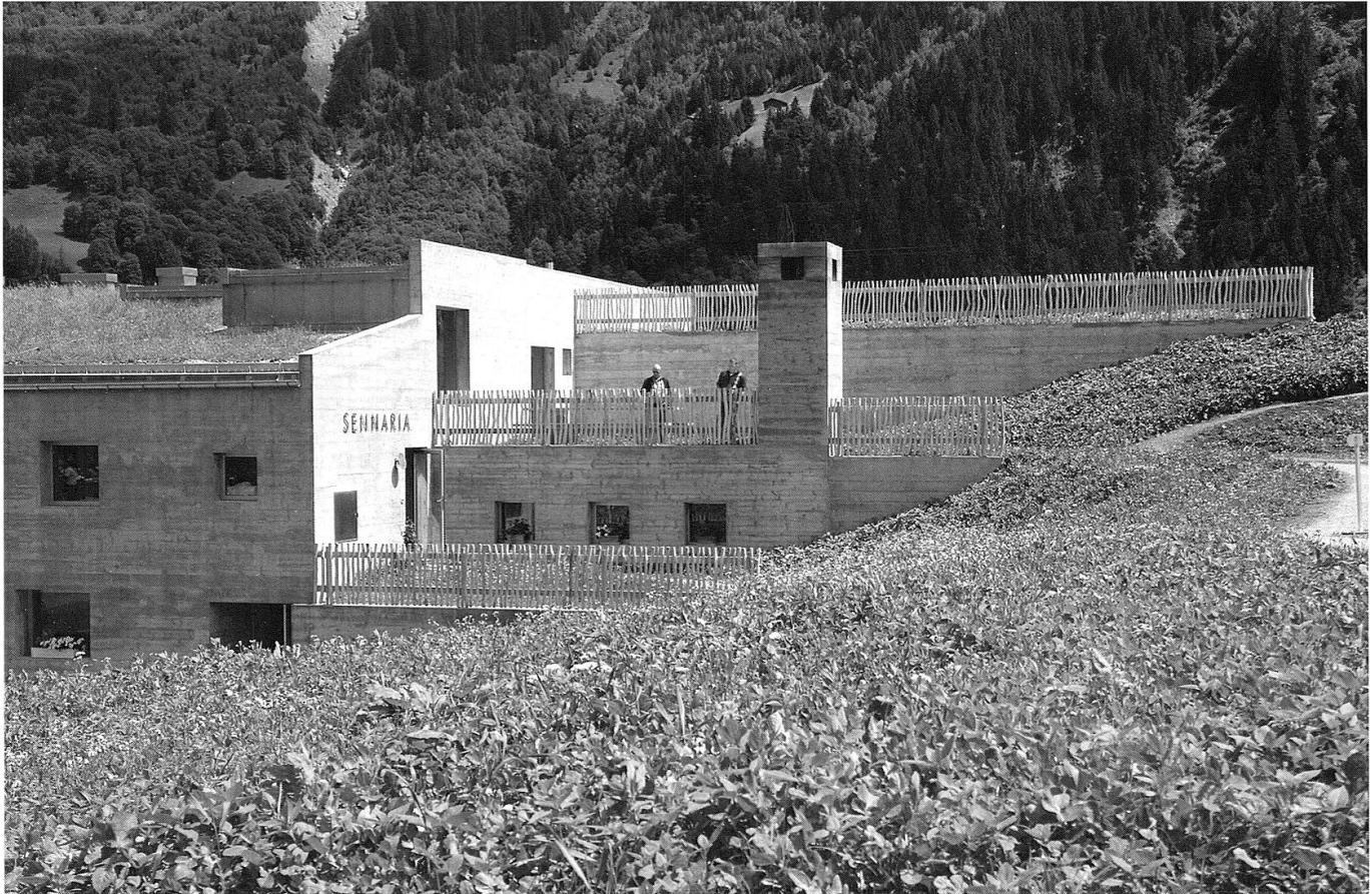
Die Sennerei in Disentis von Gion A. Caminada, 2010.
