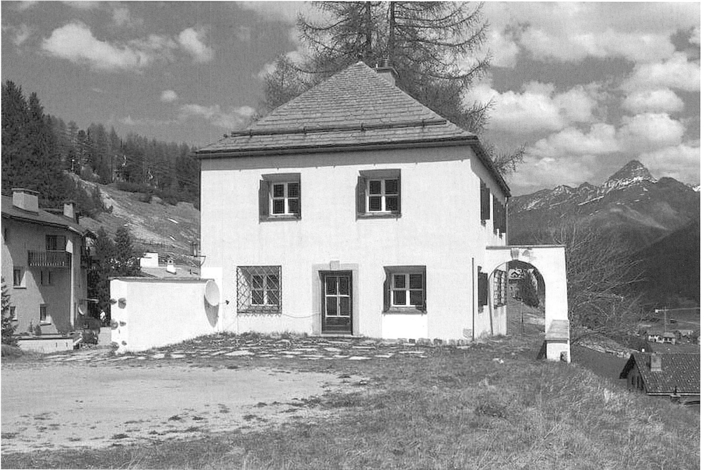
Chasa Bochert, Zuoz 1932. Bauherrin: Angelika Bochert, Architekt: Roderich Fick, Bau- leiter: Nicolaus Hartmann jun. (Lukas Frei, Zerkalo).
