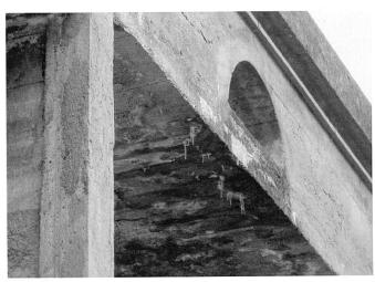
im Wesentlichen auf eine Ergänzung und Reprofilierung des beschädigten Betons konzentrieren. Wichtig ist eine kontrollierte Ableitung des Regenwassers. Heute fliesst es durch die halbkreisförmigen Aussparungen der Brüstung und durchnässt die Stirnen des Fahrbahnträgers wie die äusseren Partien des darunter liegenden Bogens. An diesen Stellen sind folgerichtig die grössten Schäden zu finden.
