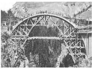
der Bogen betoniert, trägt er die anschliessend hochgeführten Aufbauten, die dadurch das Gerüst nicht mehr belasten.
