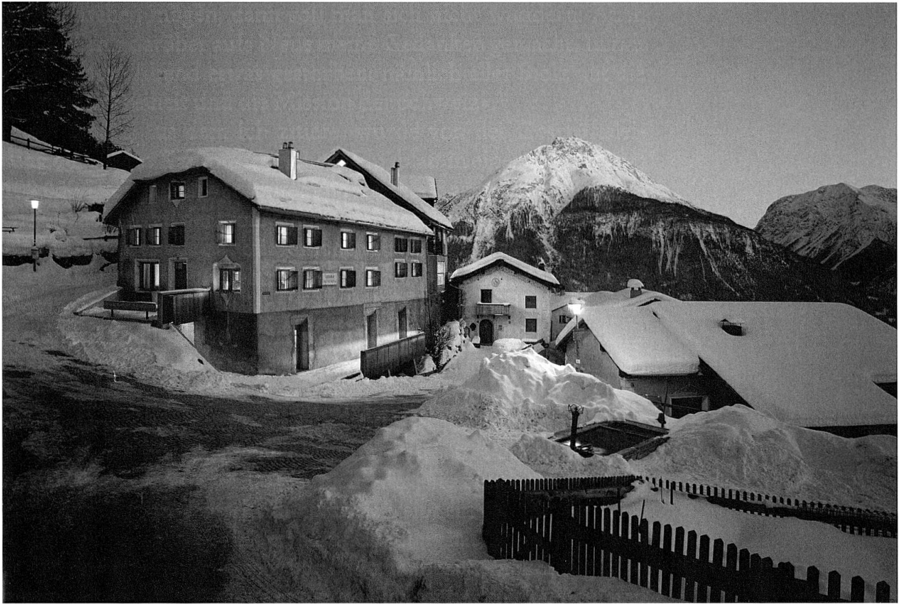
Gesamtansicht vom Dorfplatz aus.
