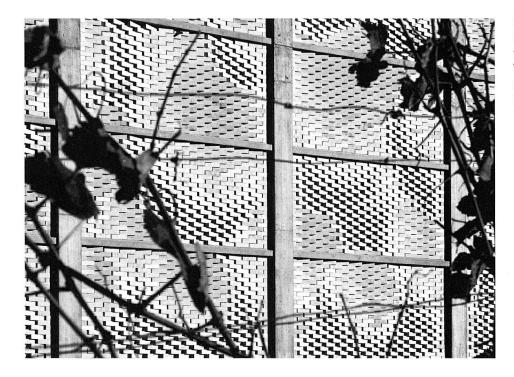
Fläsch, Weingut Gantenbein. Fassadendetail mit den mitttels Roboter gemauerten Wandelementen aus Klinkersteinen (Foto: Ralph Feiner, Malans).
