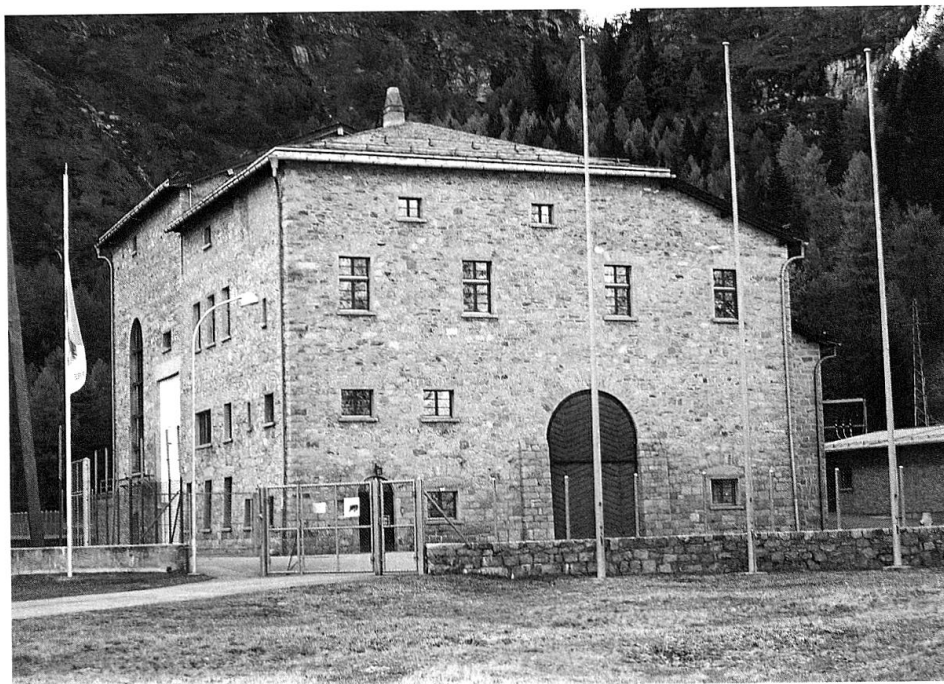
Zentrale Cavaglia der Kraft- werke Brusio AG (heute Rätia Energie AG) unweit der Berninastrecke, erbaut 1927 von Nicolaus Hartmann (L. Dosch).
