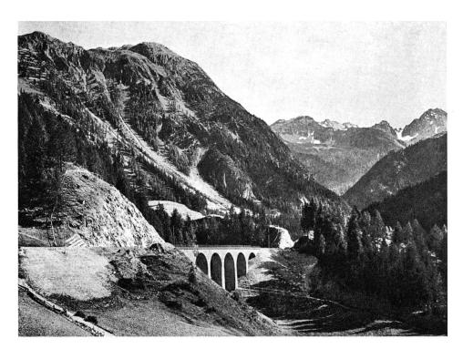
Albulastrecke. Der Clixviadukt oberhalb Bergün/Bravuogn kurz nach seiner Fertigstellung. Links oben sind die Lawinenverbauungen von Muot erkennbar (in: Friedrich Hennings. Projekt und Bau der Albulabahn. Denkschrift im Auftrage der Rhätischen Bahn. Chur 1908).
