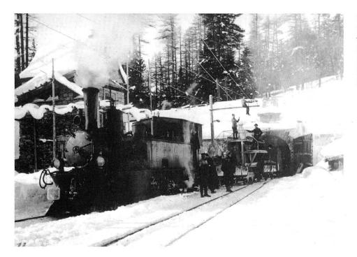
Elektrifizierung der Albulalinie. Dampflok 9¾ mit Montagezug der Unternehmung Kummler & Matter vor dem Portal des Albulatunnels in Spinas (Archiv Hermann Kummler).
