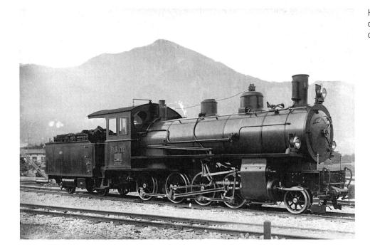
Heissdampflokomotive 1'D der RhB für den Betrieb auf der Albulalinie (RhB).
