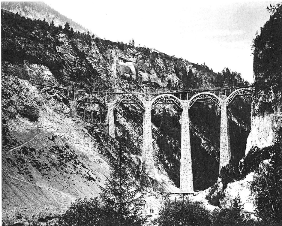
Albulastrecke. Der Landwasserviadukt bei Filisur im Bau (RhB).
