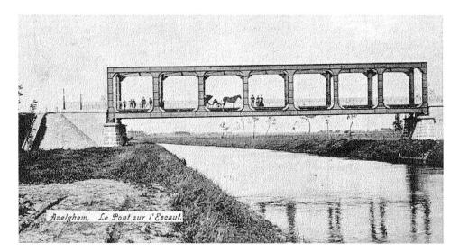
Die erste Vierendeel-Brücke über die Schelde bei Avelghem, 1904 (Vlaamse Vereiniging voor Industriele Archeologie).
