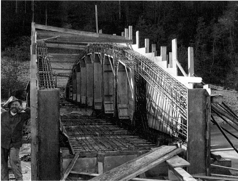
Die Dalvazzabrücke im Bau (Tiefbauamt Graubünden, Er- haltung Kunstbauten).
