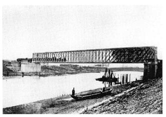
Abb. 3 Eine eiserne Balkenbrücke üblicher Konstruktion bei Griethausen/Rhein
