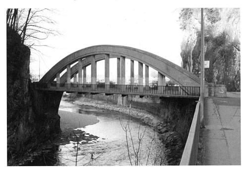
Die «Vereinigungsbrücke» in Feldkirch als weitere Bogenbrücke mit tiefliegender Fahrbahn, errichtet 1927/28. Hier übernimmt der Bogen allein die Biegebeanspruchungen, die Hänger bestehen aus einbetonierten Zugstangen. Dieser Brückentyp wurde von Friedrich Hartmann wegen den «Missverhältnissen» der einzelnen Bauteile kritisiert (Foto: Jürg Conzett, Chur).
