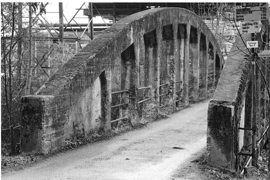
Betonierter Vierendeel-Träger mit parabolischem Obergurt: Dalvazza- brücke (Foto: Andreas Kessler, Igis).
