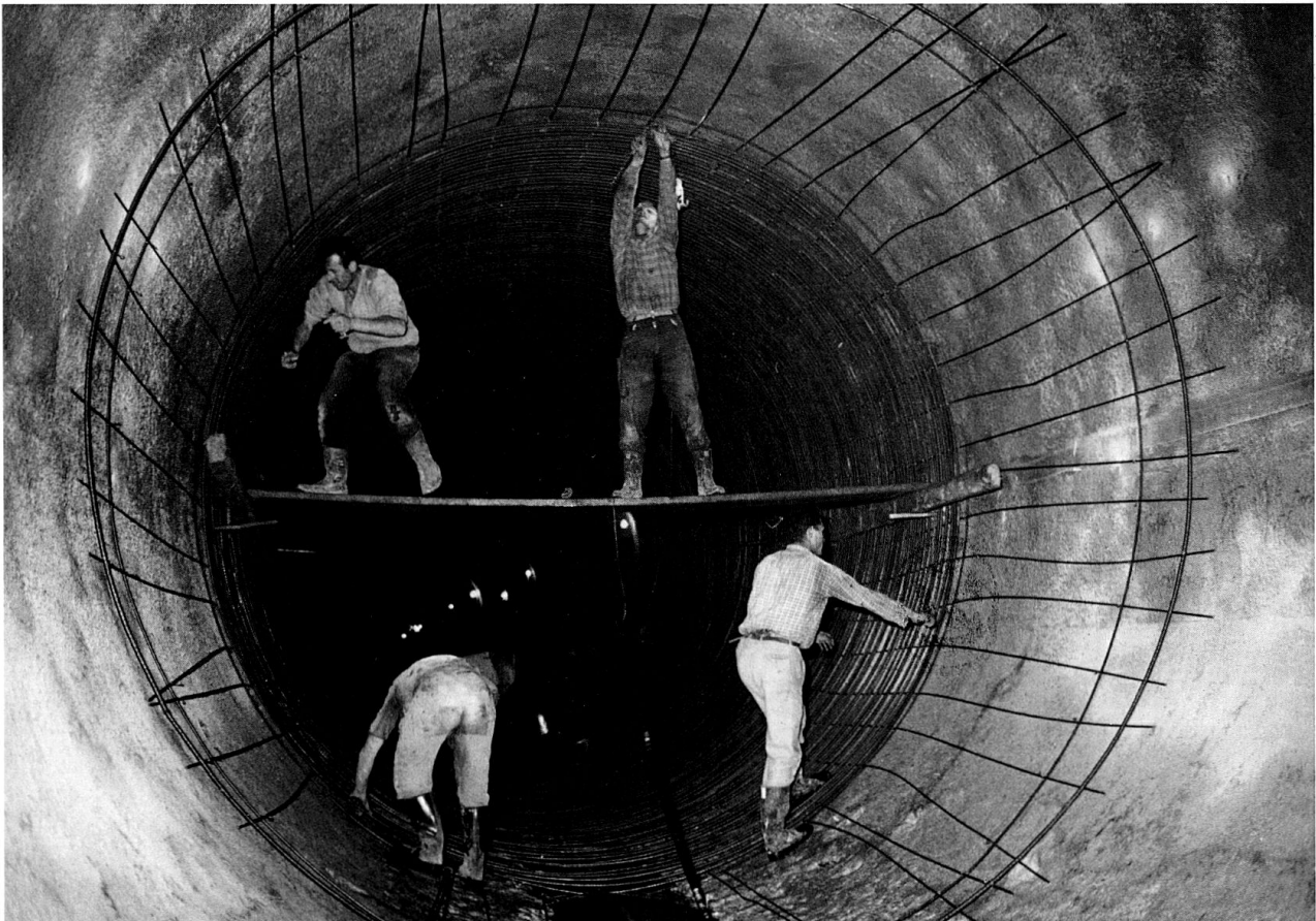
Baustelle Tavanasa, 11.8.1960: Druckstollen, Gunitstrecke, Tm 545. Eisenlegerequipe am Verlegen der Armierungsringe. Hinten fertig verlegte Strecke, vorn Verteileisen mit Montagering (der dünnere der vorderen beiden Eisen). Am Gewölbe der erste Gunitsprutz (vor dem Verlegen der Eisen aufgebracht) von 1/2 – 1 cm Stärke, sichtbar.
