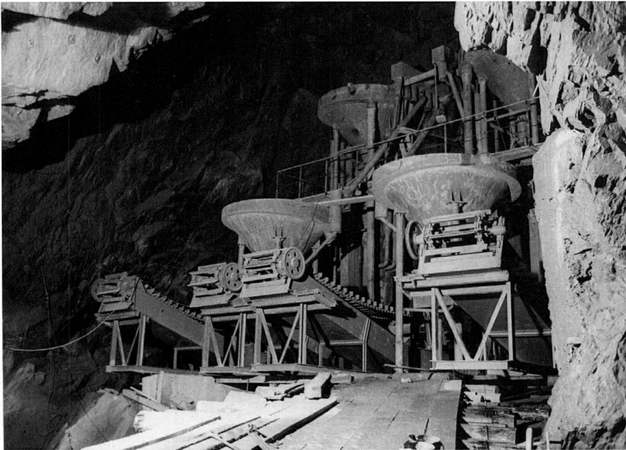
Baustelle Curnera, 23.7.1963: Rheaxanlage mit Ketteneindicker während der Montage in einer Fels- kaverne.
