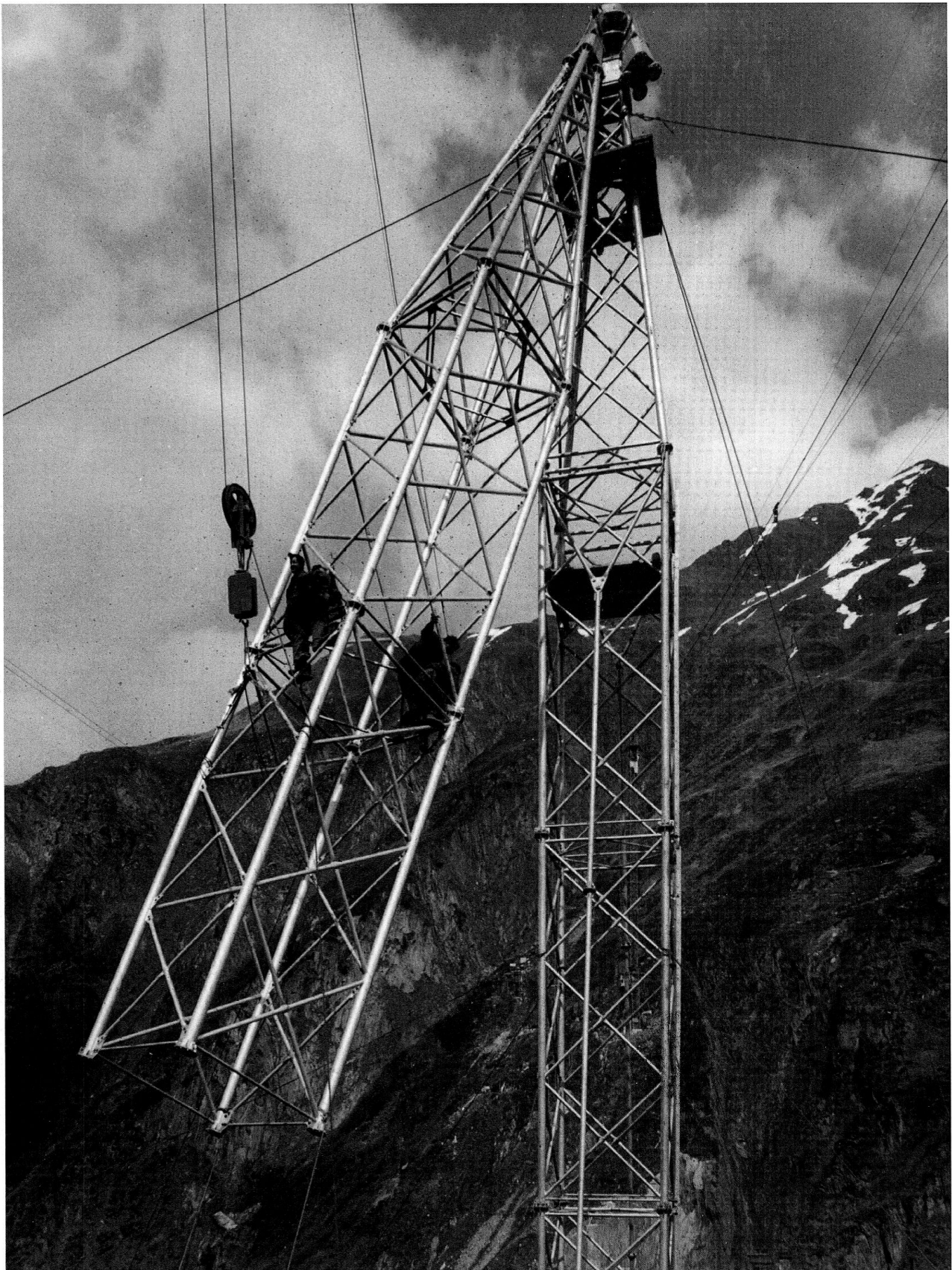
Baustelle Curnera, 5.6.1964: Detail der Montage der einen seitlichen Verstrebung am vertikalen Pylon des Derricks.
