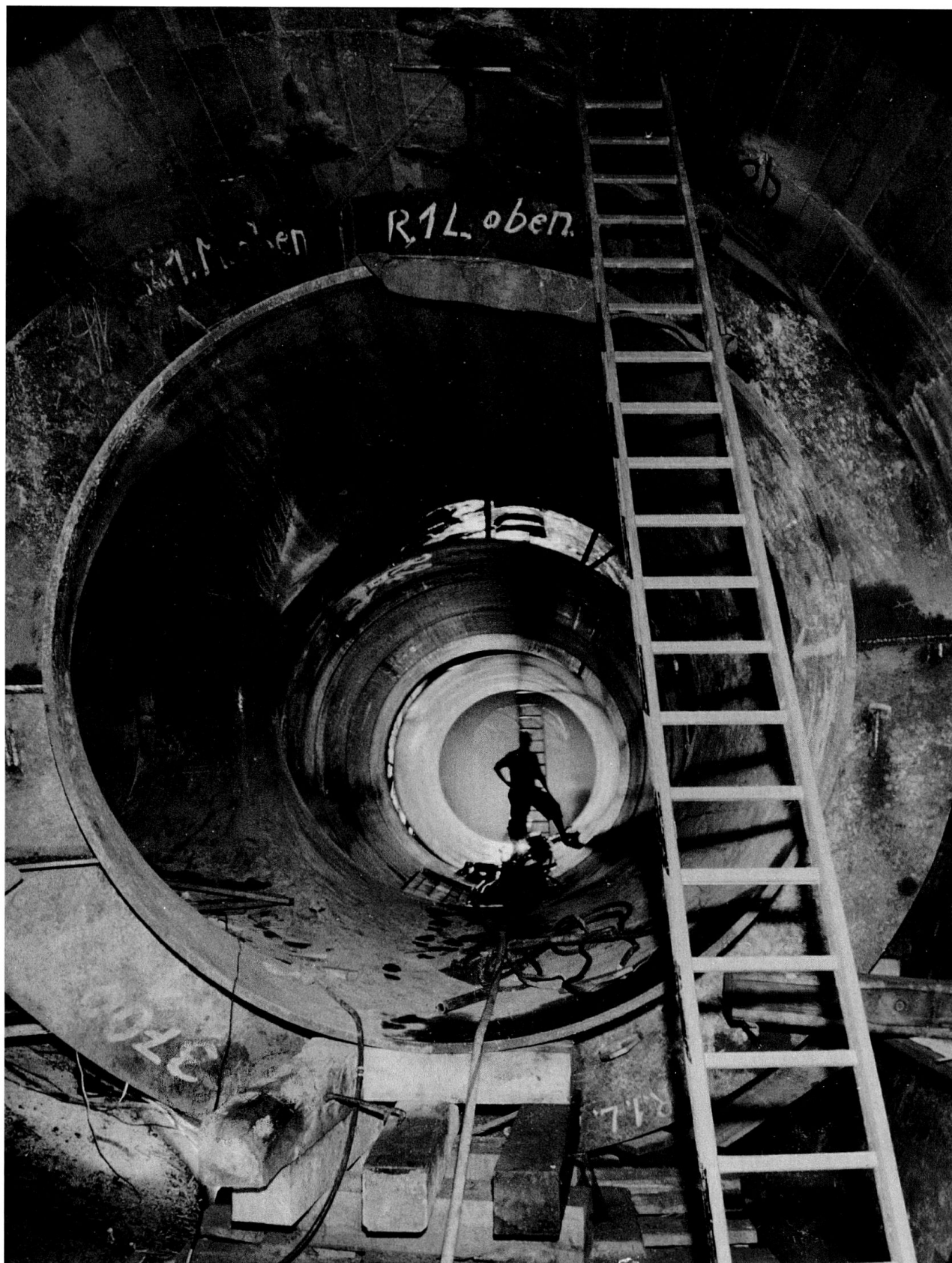
Baustelle Tavanasa, 30.7.1960: Hosenrohr Nr. 1 der Verteilleitung mit angehefteten Kragenblechen. Im Verbindungsstollen sind die Rohre Nr. 2 und 3 zum Anstellen bereit.
