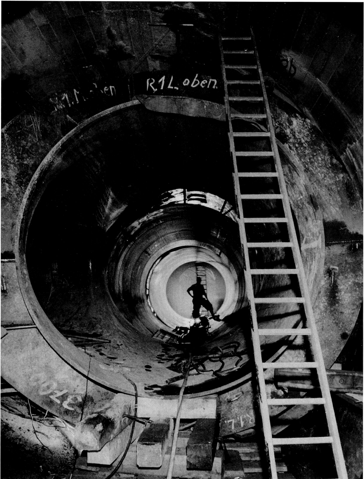
Baustelle Tavanasa, 30.7.1960: Hosenrohr Nr. 1 der Verteilung mit angehefteten Kragenblechen. Im Verbindungsstellen sind die Rohre Nr. 2 und 3 zum Anstellen bereit.
