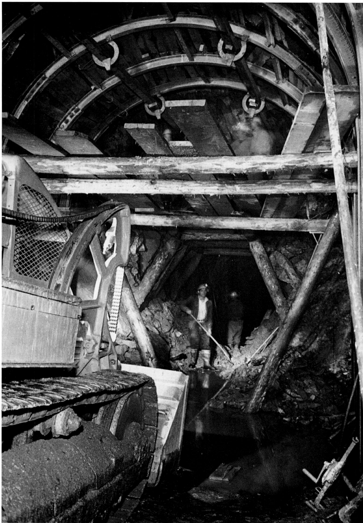
Baustelle Sedrun, 6.10.1958: Ausweitung des Zugangsstollens.
