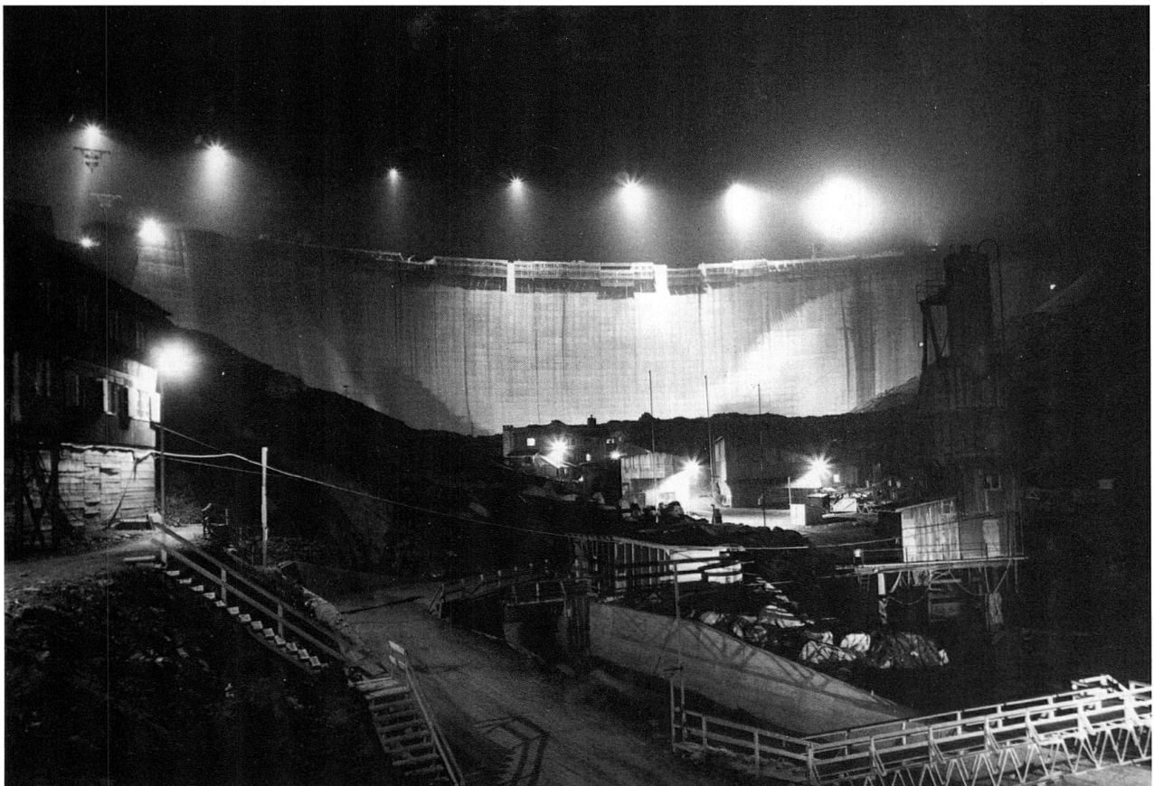
Baustelle Sta. Maria, 10.7.1967: Staumauer mit Barackendorf bei Nacht. Vorne Zufahrtsstrasse und Auslauf Grundablass Hochwasserentlastung.
