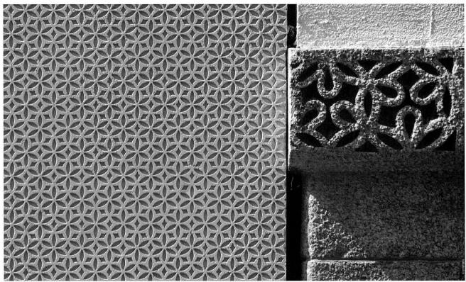
Alt- und Neubau trennt eine präzise Fuge. Das Rosettenmotiv des Fassadenmusters stammt aus den Steinhauerarbeiten des Altbaus.
