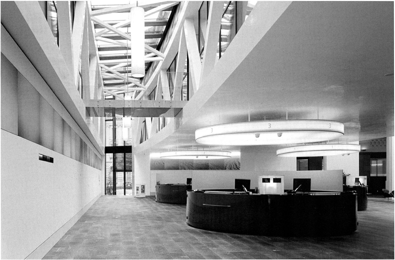
Gewaltige Betonfachwerkträger überspannen stützenlos die Kundenhalle.
