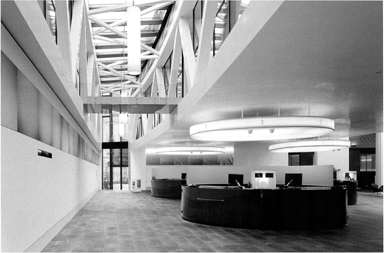
Gewaltige Betonfachwerkträger überspannen stützenlos die Kundenhalle.
