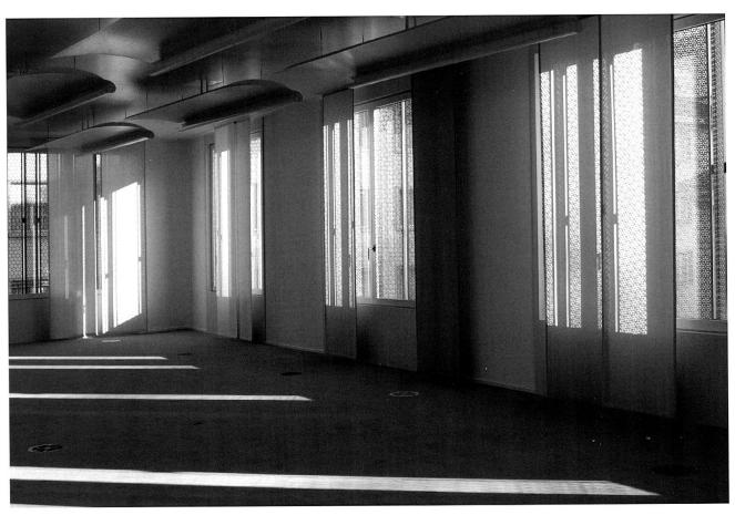
Die perforierten Fensterläden und die farbigen Vorhänge filtern in den Büros des Sonnenlicht.
