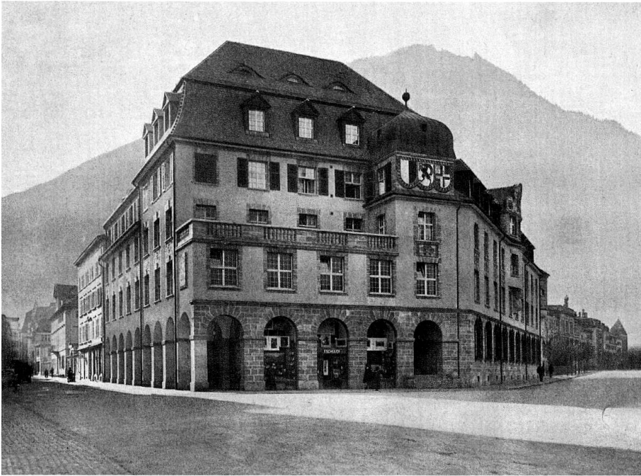
Graubündner Kantonalbank am Churer Postplatz (1909– 1911), Gesamtansicht.
