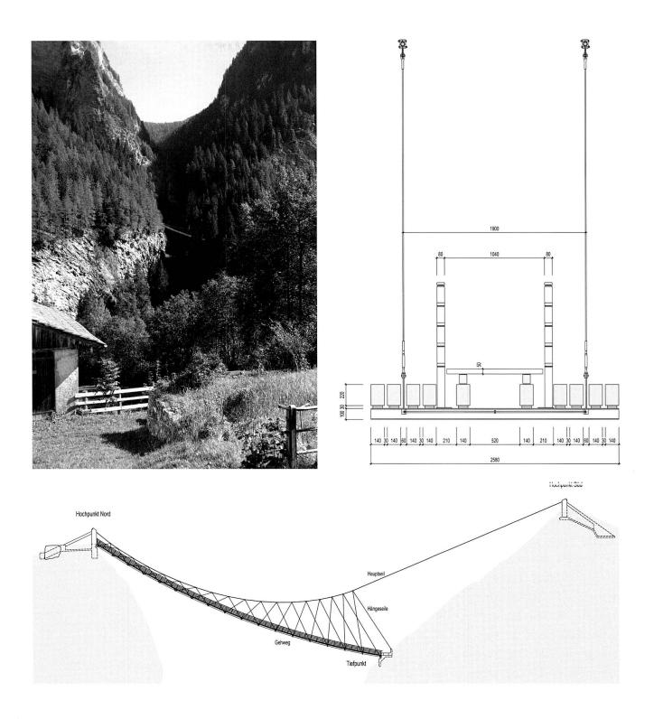
kräfte in den hinteren Teil der Widerlager und über starke Bodenplatten ins Erdreich geleitet. Als Gegengewicht wurde auf der Südseite die Bodenplatte mit Erde überschüttet; auf der Nordseite konnte ein schwerer Felsfindling zur Verankerung des Widerlagers mitverwendet werden. Die beiden Pfeiler des nördlichen oberen Widerlagers bilden einen imposanten torartigen Einstieg in die Brücke; das untere Brückenauflager, das infolge
