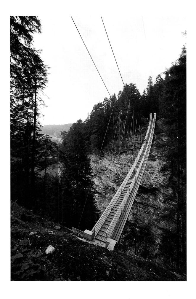
1996 wurde für die nördliche erste Etappe des Wanderwegs der Traversiner Steg als filigrane Holzkonstruktion erstellt, 1999 für die Fortsetzung durch den südlichen Teil der Schlucht die Punt da Suransuns als Spannbandbrücke, deren Gehweg mit Steinplatten aus Anderer Granit konstruiert ist. Der unterschiedlichen Materialisierung der beiden Brücken in Holz und in Stein liegt die Idee zugrunde, damit die Kulturscheide zwischen Nord und Süd zu markieren.
