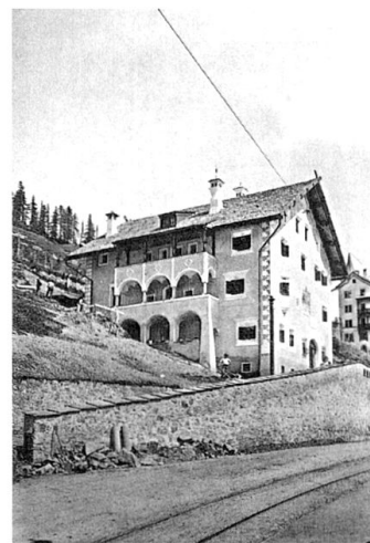
Das 1905 von Nicolaus Hartmann erbaute Engadiner Museum in St. Moritz fand als einziges zeitgenössisches Gebäude Aufnahme in der vom BHS herausgegebenen Publikation über das Engadiner Haus.
