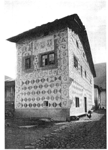
Das Haus Pedrun in Andeer mit seinem Sgraffitoschmuck aus der zweiten Hälfte des 16. Jahrhunderts wurde 1907 von Otto Schäfer «entdeckt» und bis 1909 auf Betreiben des BHS einer fachgerechten Aussenrestaurierung zugeführt. Der BHS hat diese Arbeiten auch finanziell unterstützt. (aus: Alte Bündner Bauweise und Volkskunst , hrsg. von der Bündner Vereinigung für Heimatschutz, Chur, 1914)
