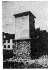
TRANSFORMATOREN- HAUSCHEN IN CHUR- WALDEN. A CHURWALDEN. UNE TOUR POUR LA TRANSFORMATION DE L'ÉNERGIE ÉLEC- TRIQUE.
