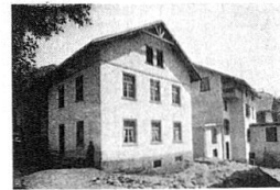
NEUE BAUERNHÄUSER IN TAMINS (nach dem Brande). Erbaut nach der imitierten unschönen Schablone FERME BANALE A TAMINS.
