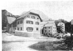
NEUE BAUERNHÄUSER IN TAMINS (nach dem Brande). Erbaut nach den Plänen der Architekten Alois & Seiler und Nik. Hartmann in St. Moritz. UNE FERME MODERNE A TAMINS. V'après les plans des architectes Alois & Seiler et Hartmann à St. Moritz.
