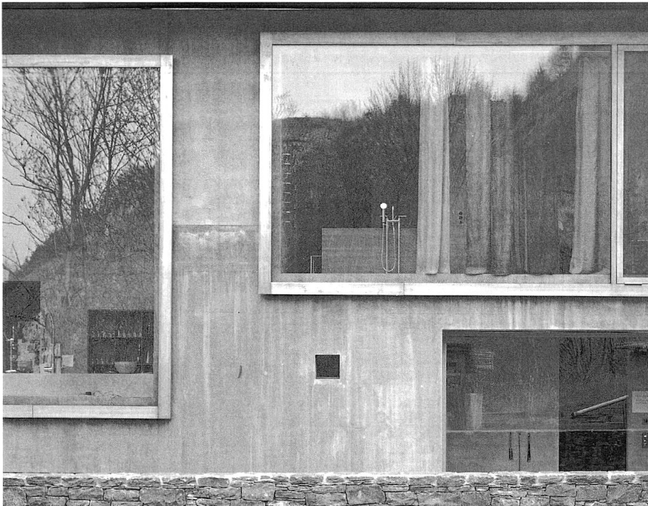
Detail der Aussenfassade des Wohntraktes.
