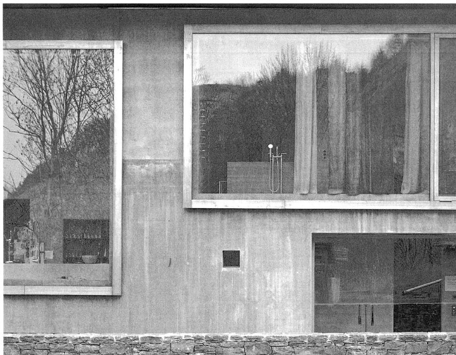
Detail der Aussenfassade des Wohntraktes.
