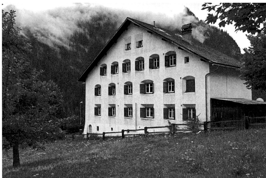
Ehemaliges Dienstwohnhaus der RhB.
