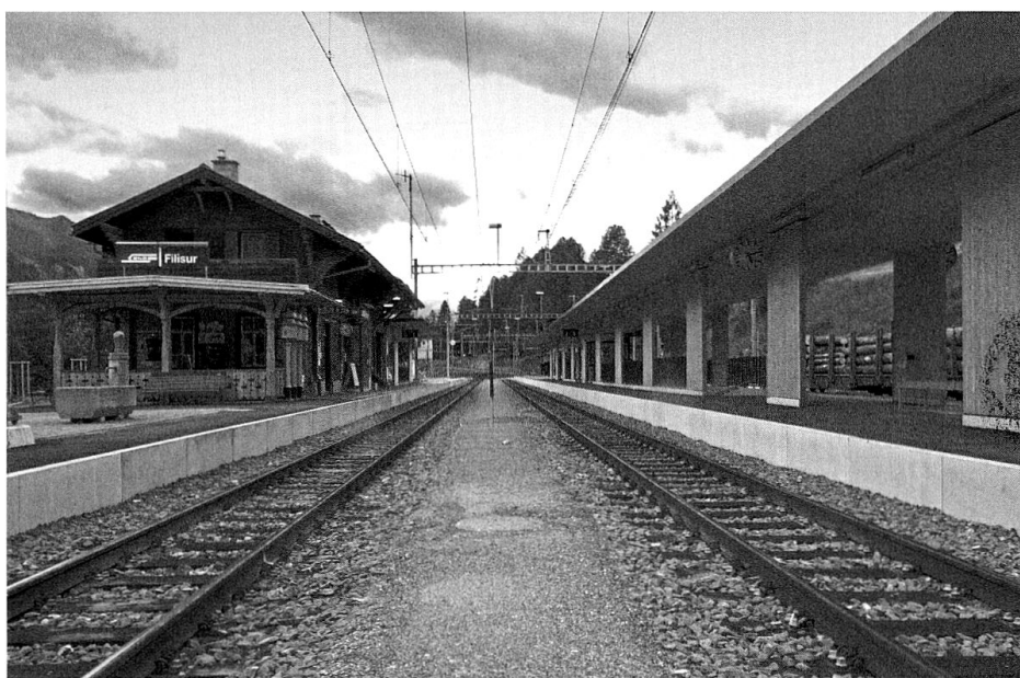
Bahnhof Filisur mit der neuen Perronanlage.
