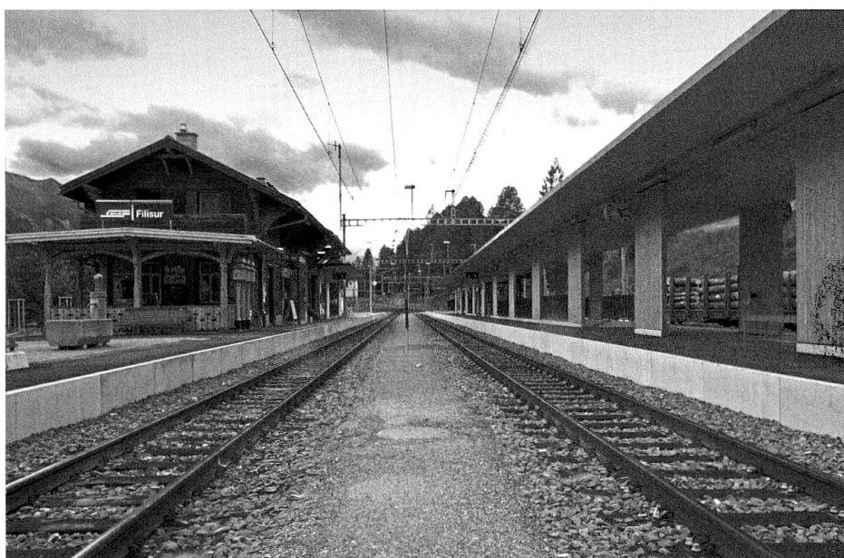
Bahnhof Filisur mit der neuen Perronanlage.
