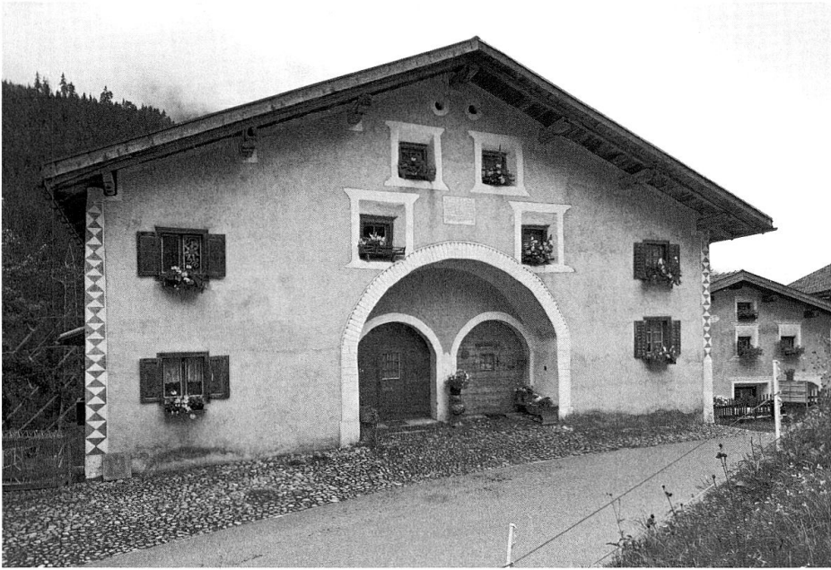
Doppelhaus Nr. 7 (Ambühl) mit mächtiger Rundbogen- nische.
