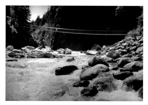
Pùnt da Suransuns von Jürg Conzett 2000. Diese Bandbrücke nützt auf raffinierte Weise die hervorragende Druckfestigkeit des Granits aus Andeer und die Zugfestigkeit der darunter liegenden Stahlbänder aus. Dadurch entstand ein äusserst sparsamer, umgekehrter Steinbogen als Hängebrücke, die eine Idee von Hossdorf auf neue Weise interpretiert. (Foto oben: Stephan Schenk, Lüen) (Foto unten: Ingenieurbüro Conzett Bronzini Gartmann AG, Chur)
