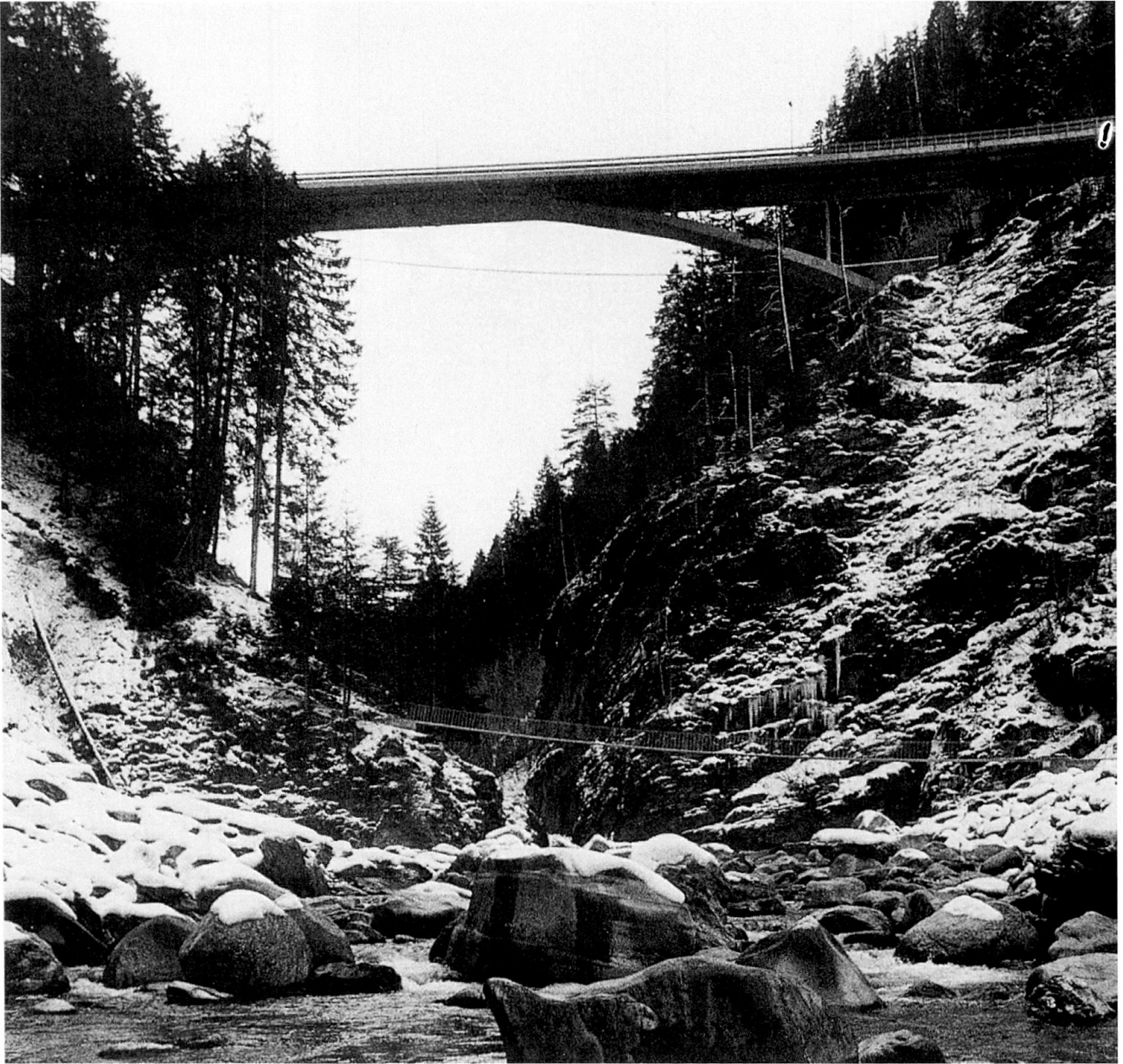
Oben die Viamalabrücke der Nationalstrasse A13 von Ingenieur Christian Menn erbaut 1966–1967; unten der Pünt da Suransuns als Teil des Fussgängerwegs durch die Viamala von Ingenieur Jürg Conzett erbaut 1999. (Foto Jürg Conzett)
