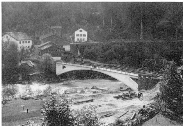
Tavanasabrücke von Robert Maillart 1905. Bei dieser Brücke öffnete Maillart erstmals den Hohlkastenträger, indem er die Seitenwände weitgehend entfernte. Somit erklärte er, wie die Brücke gebaut ist, und jeder versteht, dass sie kein traditioneller Steinbogen sein kann. (Bild links
