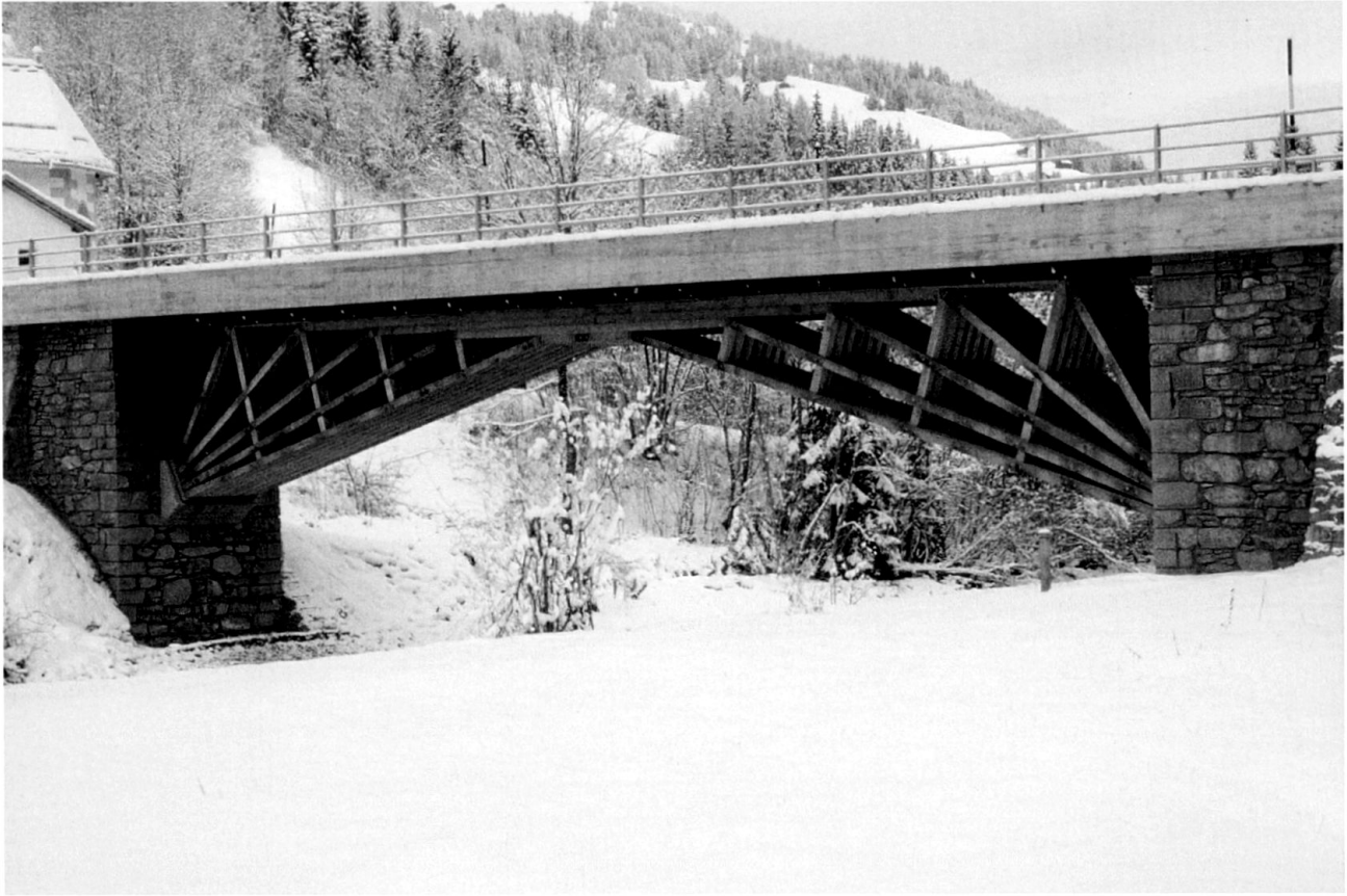
Peidenbadbrücke von Jürg Konzett. Der Holzunterbau versteift die dünne Betonfahrbahn. Die Fahrbahn schützt das Holz. Die Bauweise auf einem Lehrgerüst wird Teil der permanenten Form der Brücke. Dadurch bleibt der Bauprozess im fertigen Werk sichtbar. (Foto Martin Tschanz, Zürich)
