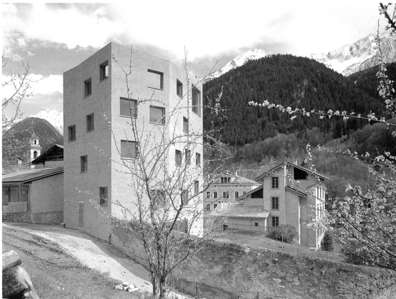
Ensemble Villa Garbald und Neubau. (Foto: Ruedi Walti, Basel, 2004.)
