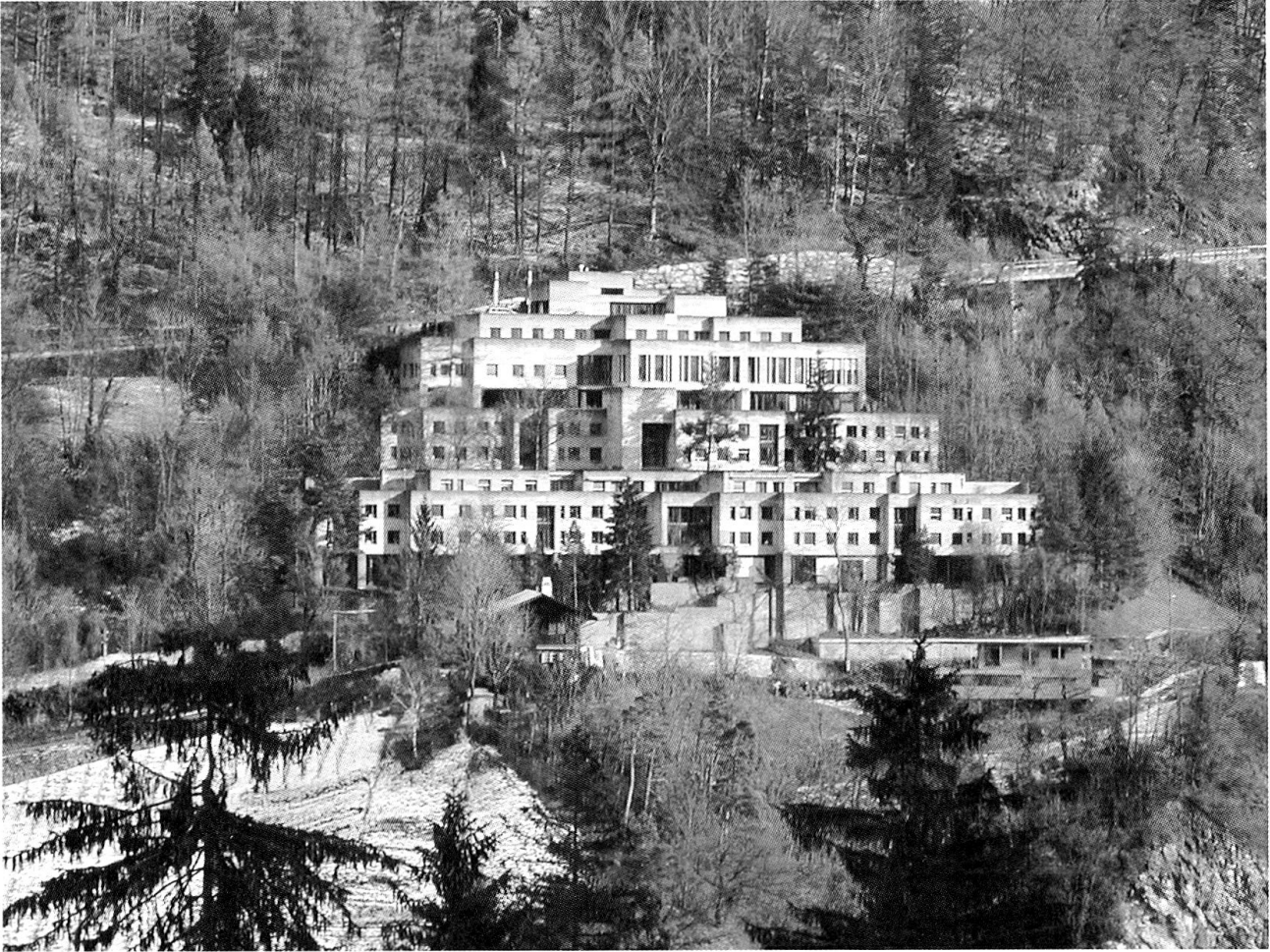
Das neue, 1967–1969 errichtete Konviktgebäude von Otto Glaus. (Foto: Michael Hanak, Zürich, 2004)
