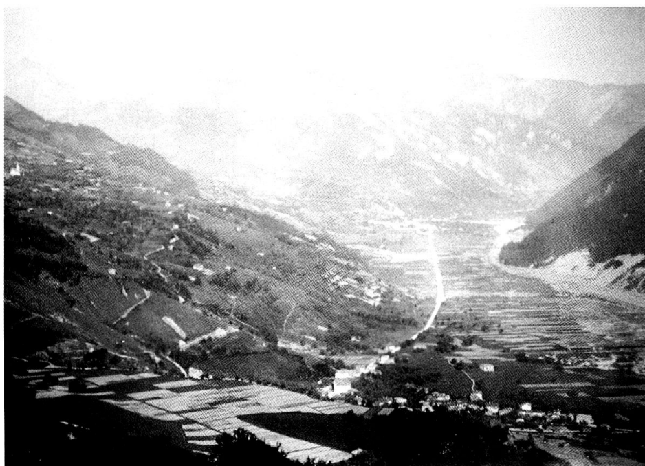
Blick über Faschnei auf Grüşch und Schiers, Fotoaufnahme von ca. 1885 (vor dem Bau der RhB 1889). Die Kolmatierung ist weit fortgeschritten; auf den «Schwellenen» breiten sich Äcker und Wiesen aus. Auffällig das helle Band der Talstrasse mit ihrem schnurgeraden Verlauf (Anlage von 1843). Die Landquart ist an den südlichen Hangfuss zurückgedrängt, aber noch nicht kanalisiert, der grosse Damm fehlt noch. In diesem Bereich zeigt sich noch etwas vom «Sand», der zu Pols Zeiten den ganzen Talboden bedeckte. (Kulturarchiv Haus zum Rosengarten, Grüşch)
