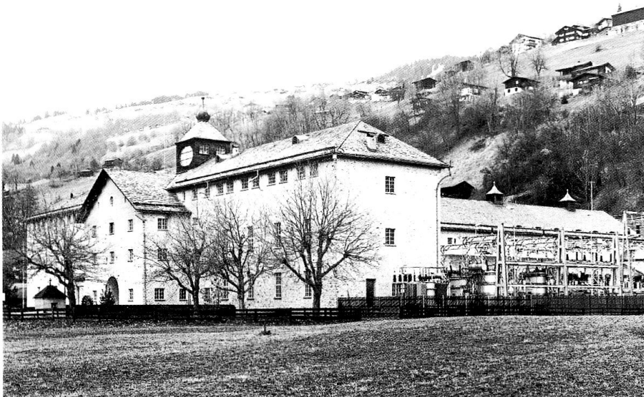
Das Kraftwerk Küblis. (Foto: Jürg Ragetti)
