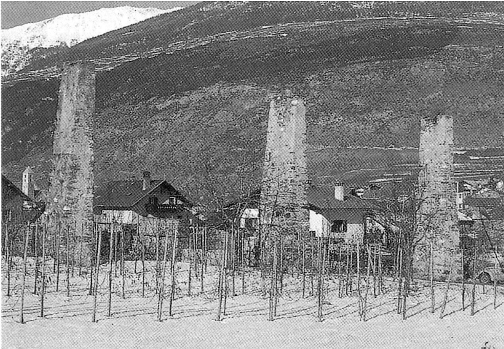
Vinschgau: Gemauerte Pfeiler des ehemaligen Laaser Kandelwaals (Bild: MENARA, Bewässerungskanäle in Südtirol, S. 149)
