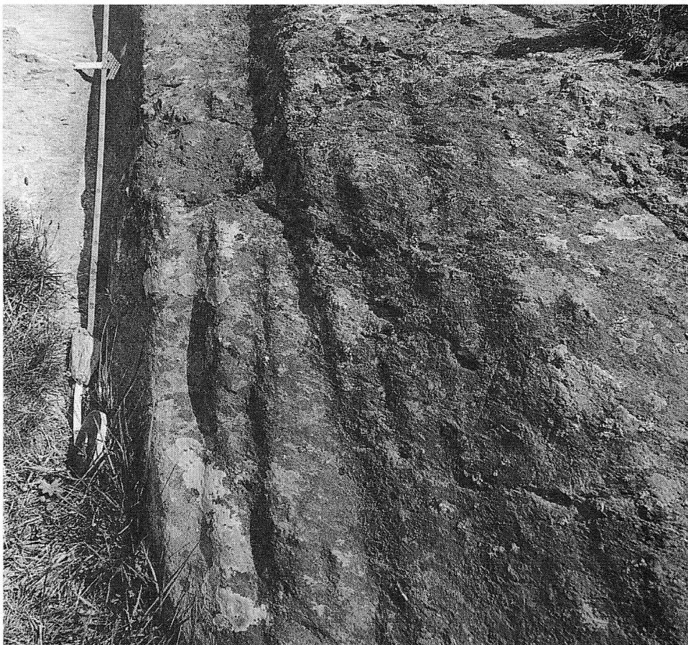
8 Parallele Rinnenrelikte entlang einer schrägen Felswand (Maloja). Sie sind erklärbar als Abarbeitung des störenden Felsriegels in zahlreichen kleinen Stufen, so dass der Verkehr gleichzeitig weiterlaufen konnte.
