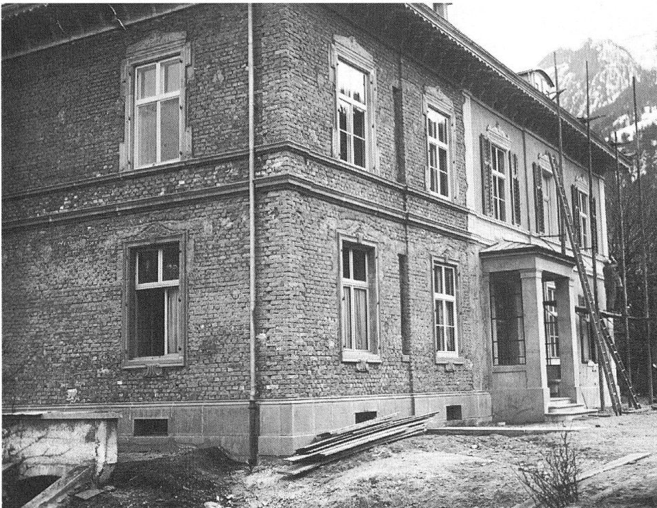
1922/23 während des Umbaus
