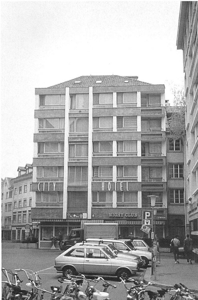
Thomas und Thomas Domenig: City-Hotel am Martinsplatz, eröffnet 1960. (Foto des Verfassers)
