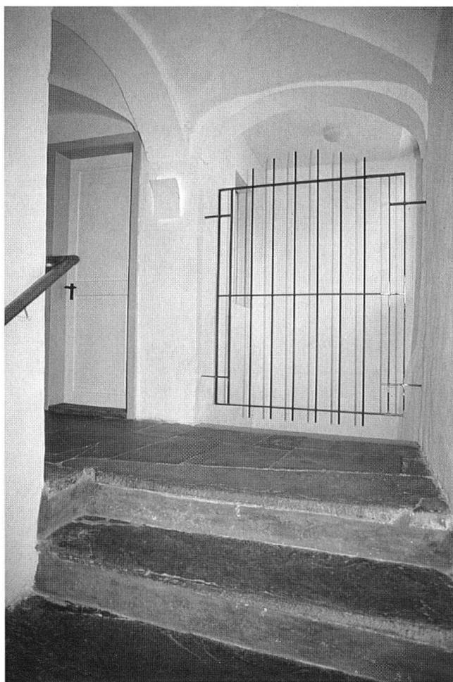
Haus Rainolter, Treppenhaus mit Eisengitter und Wandleuchte. (Foto des Verfassers)
