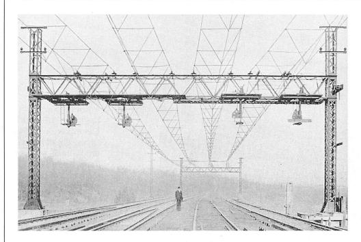
Bild 2: Starre Fahrleitung mit zwei Tragseilen (New Haven 1907).
