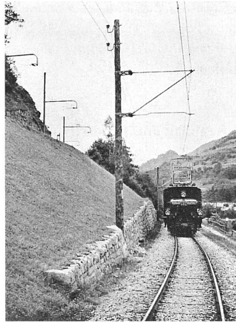
Bild 7 (links): Ausleger der schwedischen Staatsbahn
