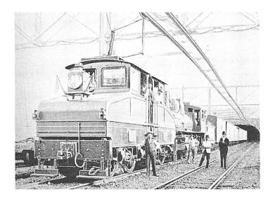
Bild 1: Tunnel-Elektrifizierung in Baltimore (USA). Die Elektrolok zieht einen Dampfzug durch den Stadttunnel. Massive Fahrleitung wegen niederer Fahrleitungsspannung.
