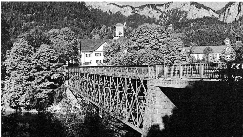
Nach dem Bau der N 13 erhielt die Brücke ein neues, bruchsteinverkleidetes Widerlager. Foto: Heini Letsch, Tamins.
