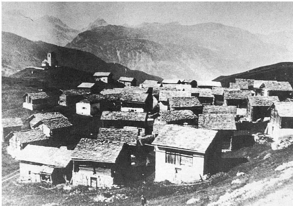
Cresta-Farera (1660 m ü.M.) zur Zeit Gieri la Tschepas. Die lawinengefährdete Zone befindet sich am nordöstlichen Dorfrand (rechts oben im Bild, wo auch das Dach des damals betroffenen Hauses zu sehen ist). (Foto: Archiv «Tgea da Schons», Schamser Talmuseum, Zillis)
