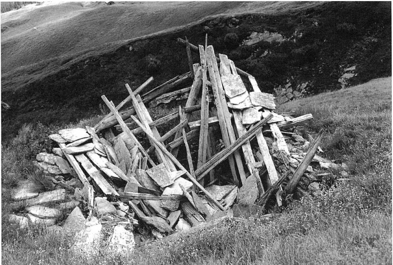
Abb. 26: Eingestürztes Dach eines «Heutachlis»; Zana
