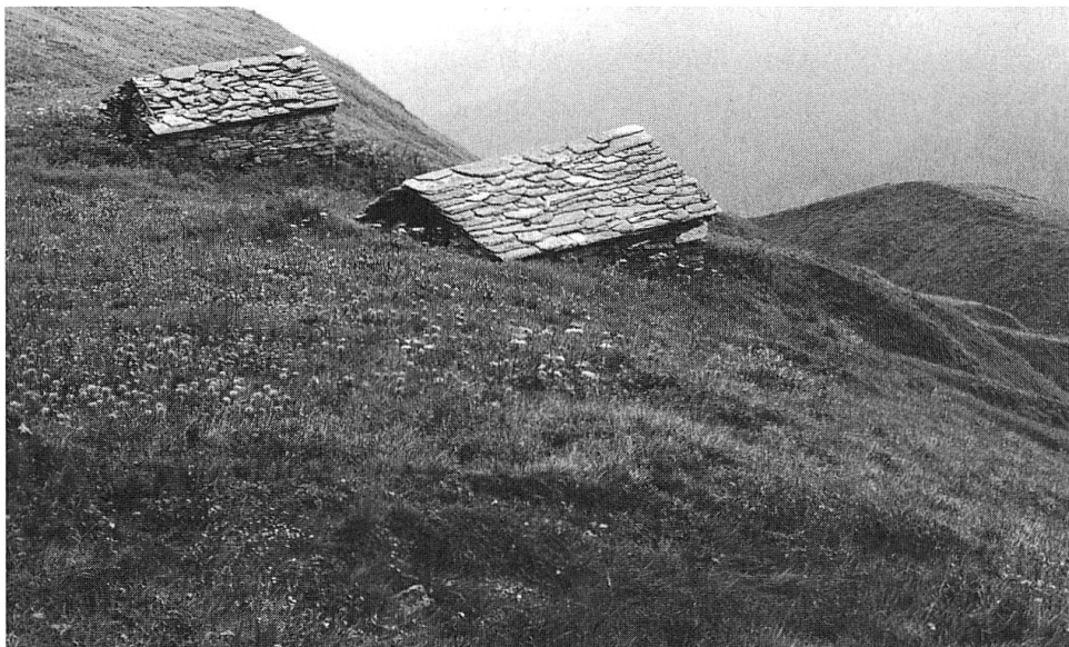
Abb. 18 Überwachsene Hausmulde eines «Heutachlis». Im Hintergrund die Dächer zweier gut erhaltener «Heutachlis»; Leiser Heuberge
