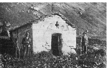
Abb. 10 Unter Einbezug eines Felsbrockens trocken aufgeführte Hausmauer; Blachtenalp
