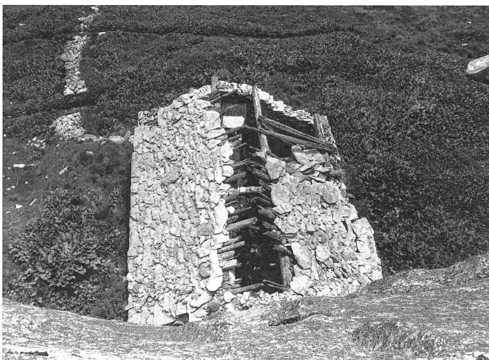
Abb. 9: Stark beschädigtes Dach eines «Stalles»; Etzmeder
