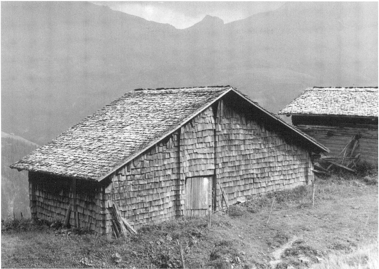
Abb. 33: Verschindelte Wetter- seite eines Sammel- baus bei den Zalöner Hütten
