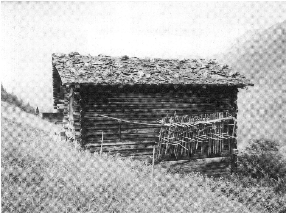
Abb. 32: Usser Bircha: Mit Steinen beschwer- tes Schindeldach (Schwardach)
