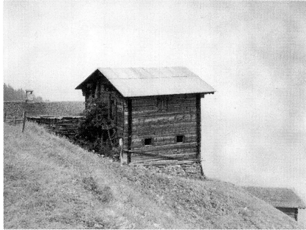
Abb. 18: Stubenstrick in Bruschgaleschg. Küchentrakt und Mittelkorridor abge- gangen
