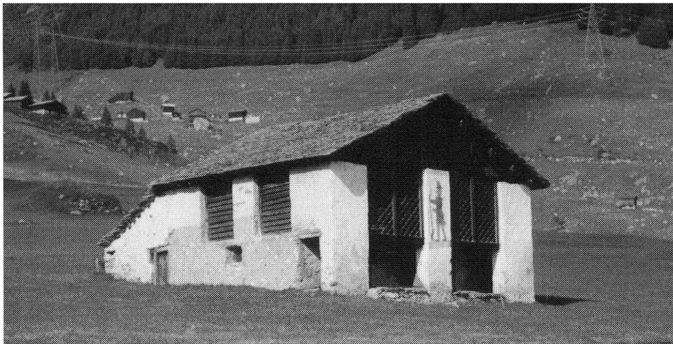
Abb. 13: «Plaun Sut» oberhalb Rueras. Gemauerter Pfeilerbau mit Steinplattendach, datiert 1864.
