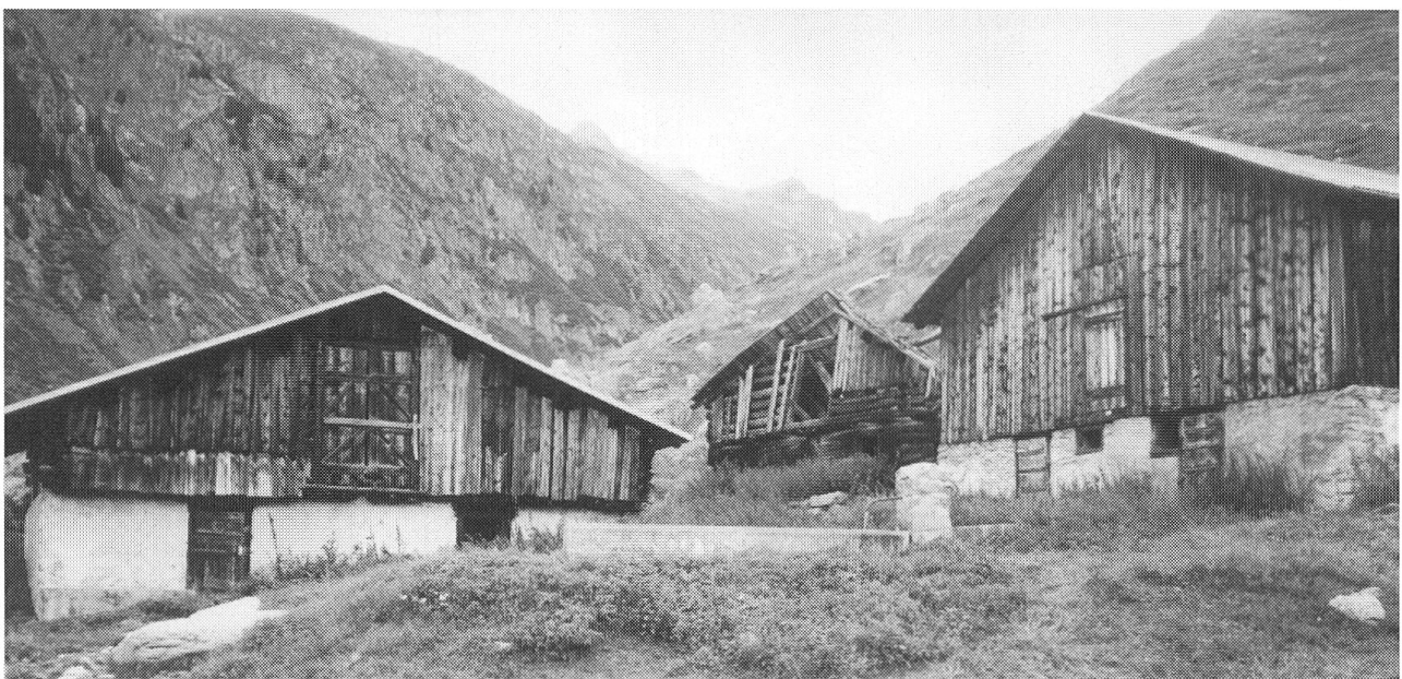
Abb. 12: «Valtgeva» (Pt.1548). Die jüngere Gebäudegeneration mit gemauerten Stallteilen um 1920; im Hintergrund ein zerfallender Vorgängerbau in Holzbauweise (um 1850).
