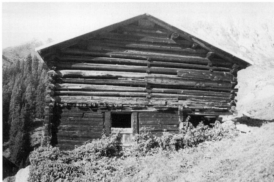
Abb. 22: «Mila» (Pt.1647). Der Heuraum über dem bestehenden Einer-Stall wurde um 1900 seitlich er- weitert.
