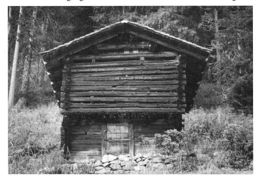
Abb. 10: Giebelseitig erschlossene Einer-Stallscheune (um 1850) bei «Tscheppa» (Pt.1392)
