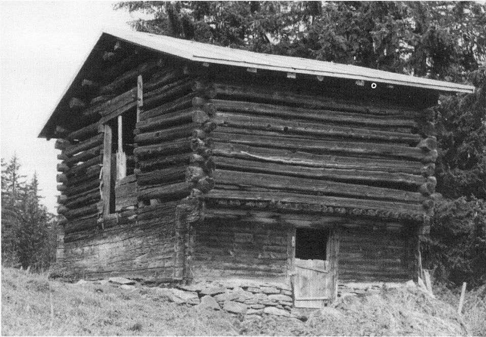
Abb. 11: Traufseitig erschlossene Einer-Stallscheune (um 1880) bei «Capetsch» (Pt.1483).
