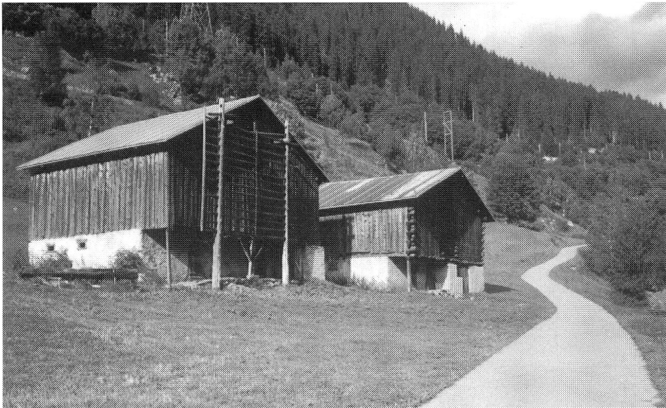
Abb. 19: Aussenställe (Um- bau um 1920) bei «Bagliel» (Pt.1322).
