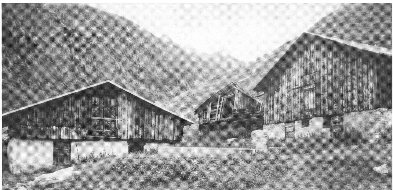
Abb. 12: «Valtgeva» (Pt.1548). Die jüngere Gebäudegeneration mit gemauerten Stallteilen um 1920; im Hintergrund ein zerfallender Vorgängerbau in Holzbauweise (um 1850).
