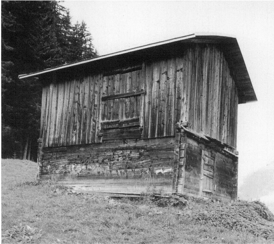
Abb. 21: Stallscheune mit vergrössertem Heu- raum (um 1930) bei «Capetsch» (Pt.1446).
