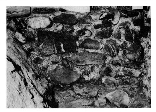
Abb. 6: Chur, Kapelle St. Stephan: Tonne von oben an der Südseite mit Erweiterungsanschluss, der Feuchtigkeit bringt.
