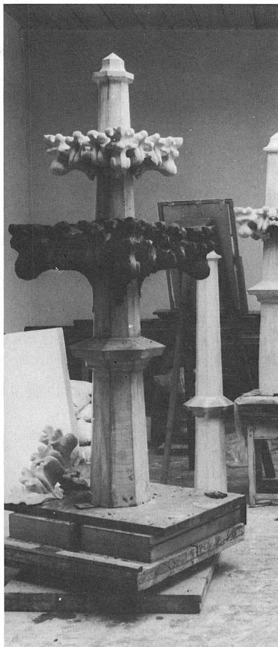
Abb. 2.4: Nach der Restaurierung mit den nach dem Original rekonstruierten Türmchen und Fialen.
