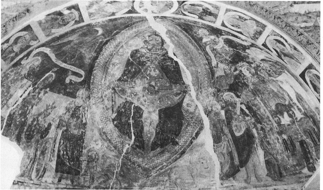
Abb. 8. Fex-Crasta, Kapelle, geöffneter Riss in der Apsiskalotte.
