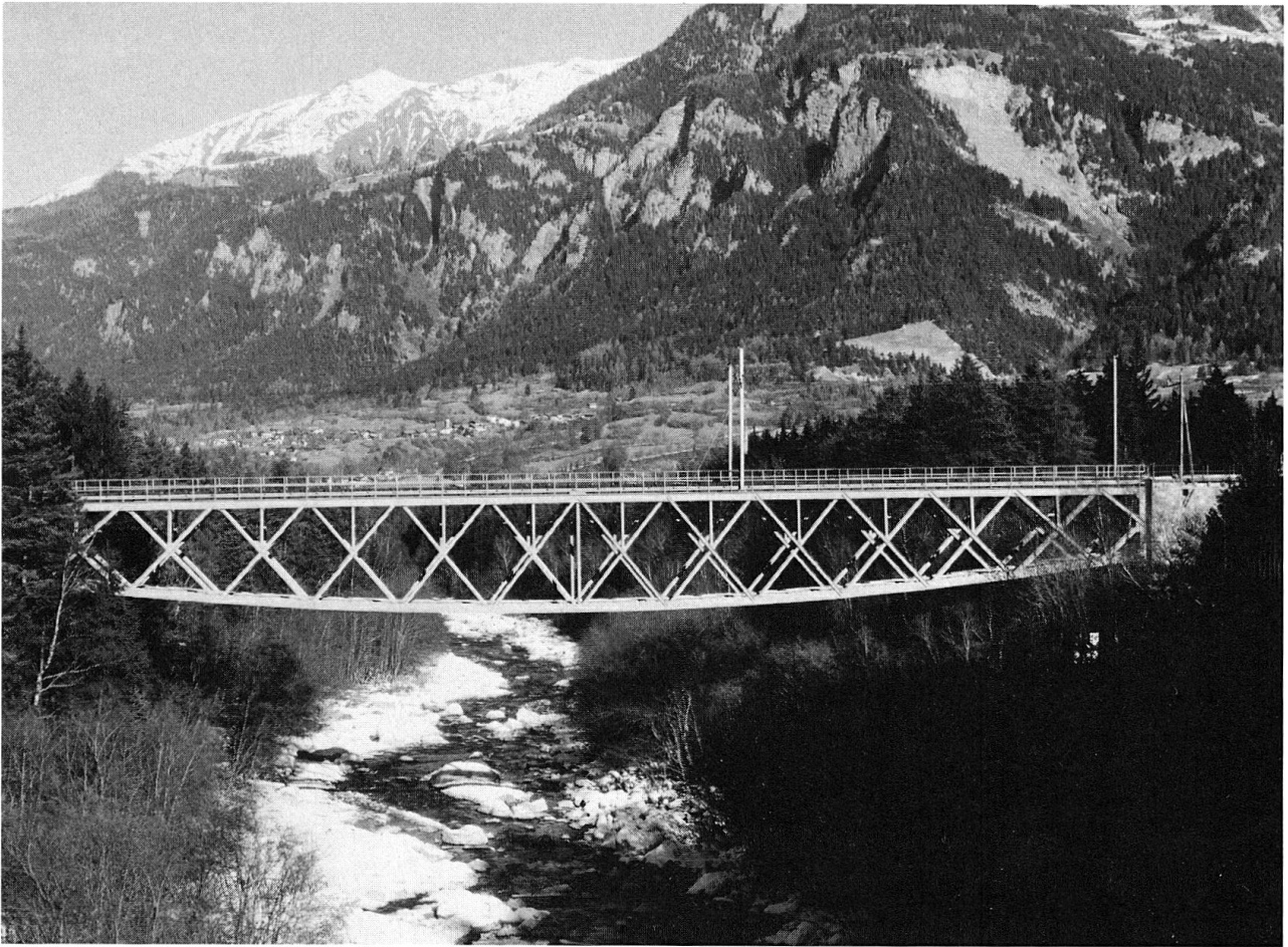
Rheinbrücke Thusis, Zustand Ende 1988.
