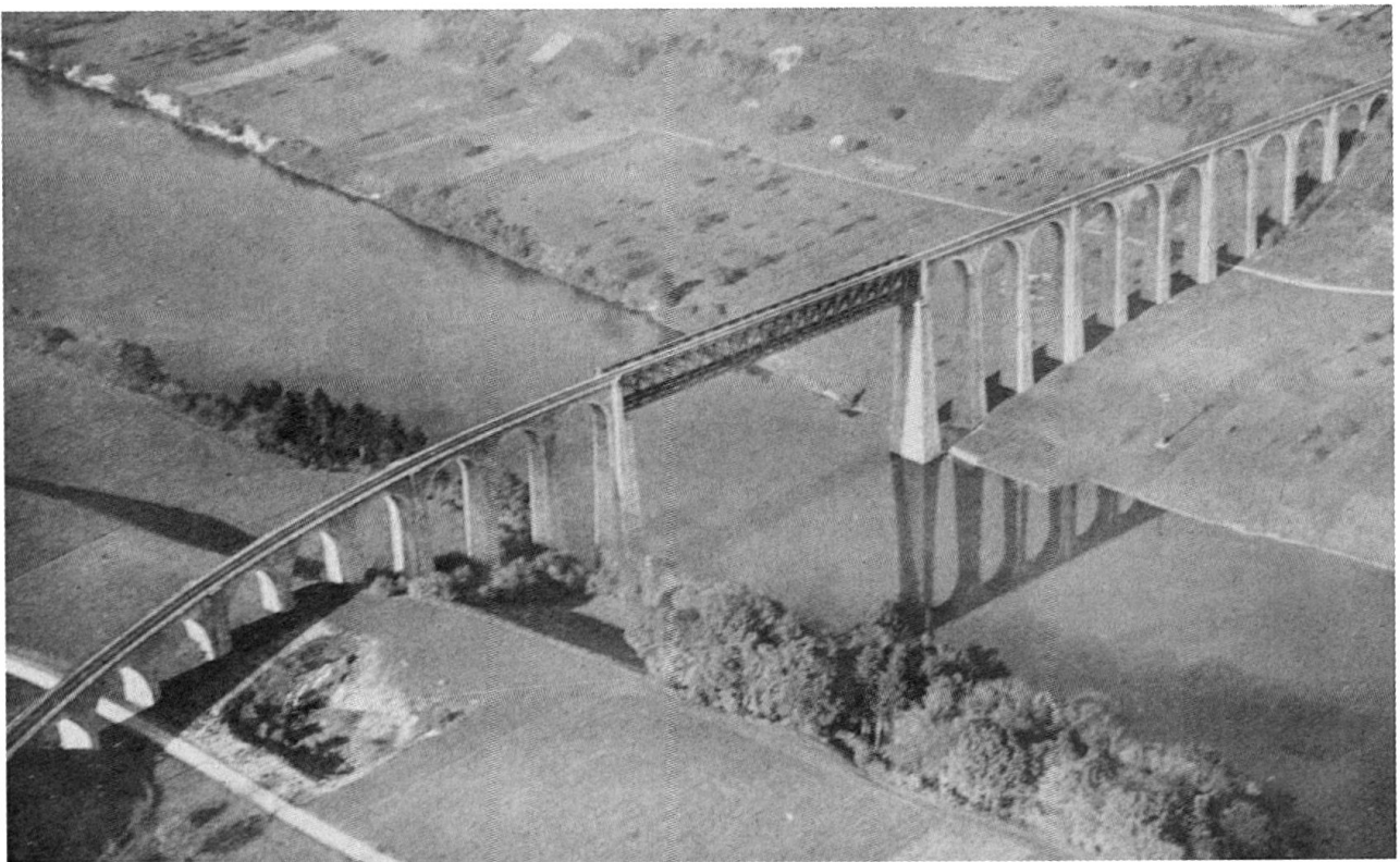
Rheinbrücke bei Eglisau.
