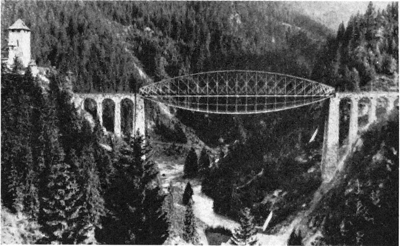
Trisannabrücke der Arlbergbahn.
