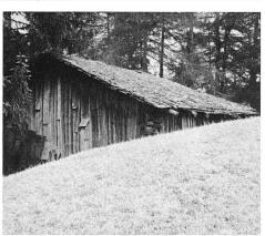
\_\_Oben: Die Hütte (links) und die Stallscheune sind unter dem gleichen \_\_ Giebel vereint. Leider ist der Zerfall dieses altertümlichen Typus vor 1800 weit fortgeschritten. Die Bilder zeigen den Hocheinwurf, \_\_ die knappe Fundierung, das Schindeldach.
