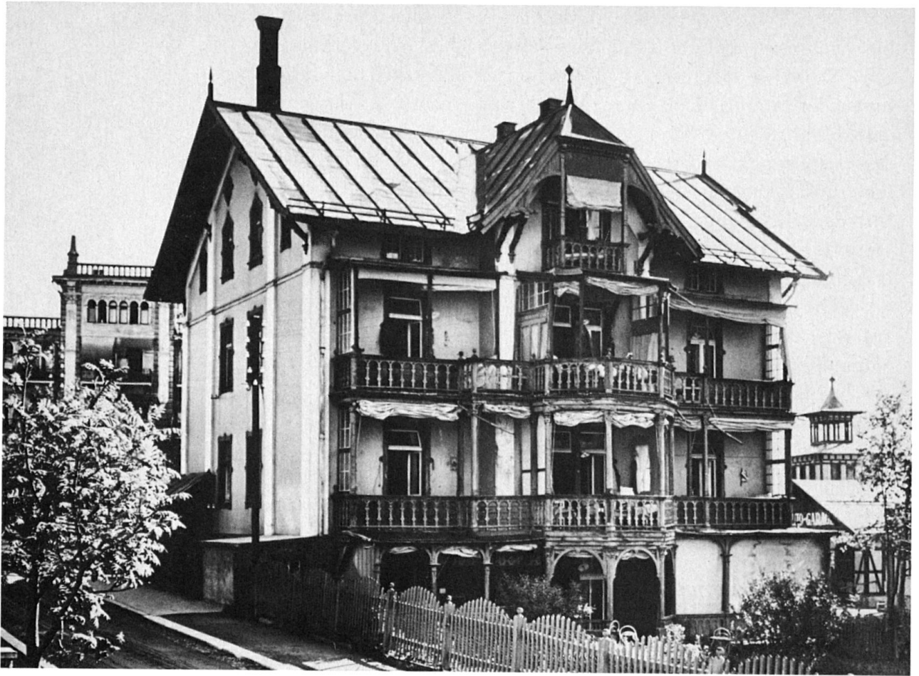
Vorher: Heilstätte «Villa Sophia» vor dem Umbau durch Rudolf Gaberel.
