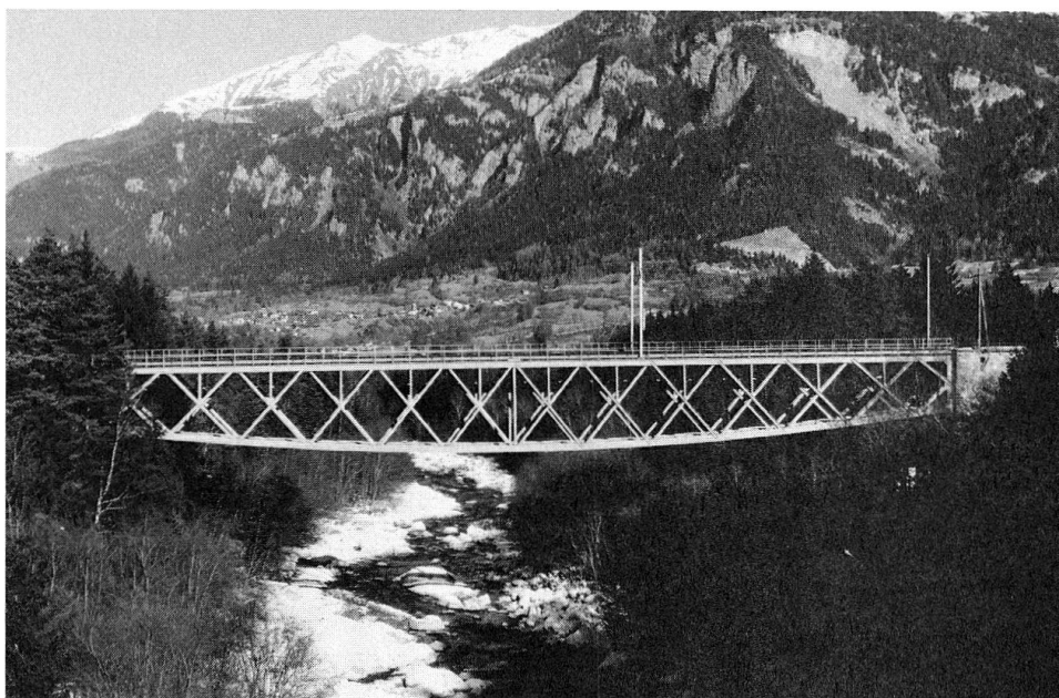
Die Hinterrhein- brücke bei Thusis
