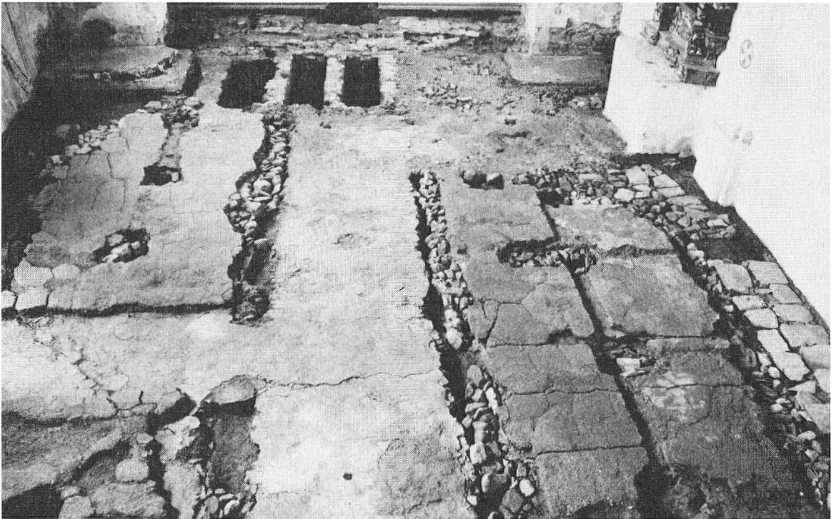
Abb. 6. Erhöht barocker Mörtelboden und Steinplatten längs der Nordmauer, im Mittel- und Seitengang romanischer Mörtelboden von Osten
