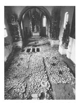
Abb. 8. Rollierung zum romanischen Mörtelboden mit Taufsteinsockelfundament von Osten
