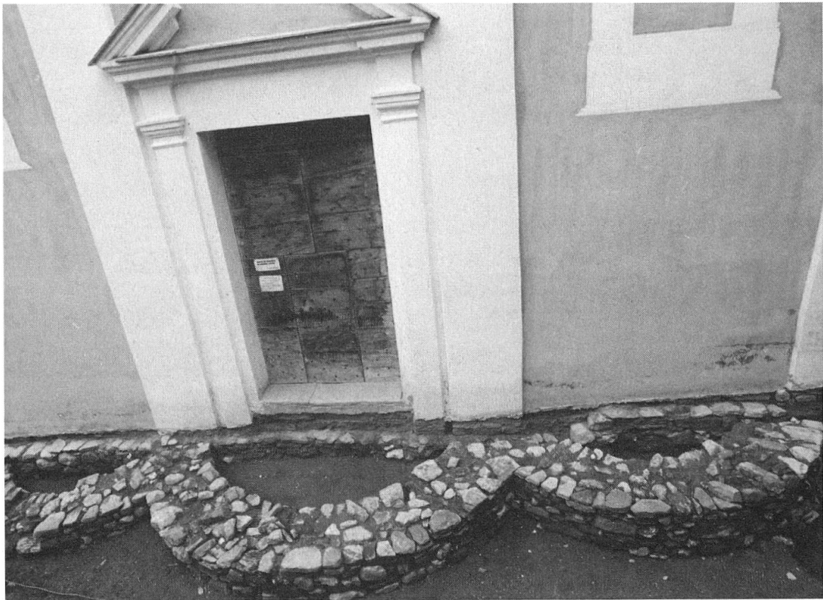
Abb. 2. Die Fundamente der Apsiden von Osten
