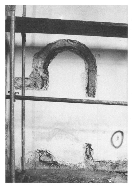
Abb. 9. Zugemauerter gotischer Sakristeieingang von Süden
