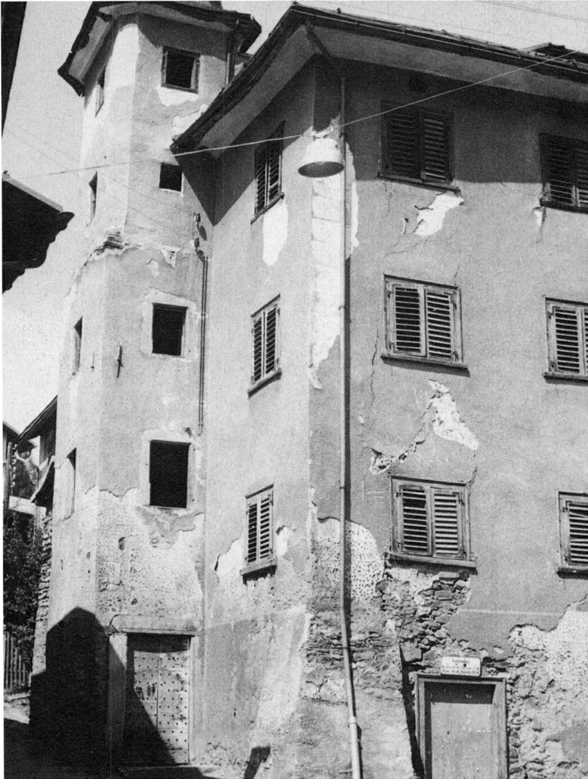
Das «Türali»-Herrschaftshaus in Valendas ist auch ein Marchion-Gebäude und sollte restauriert werden.
