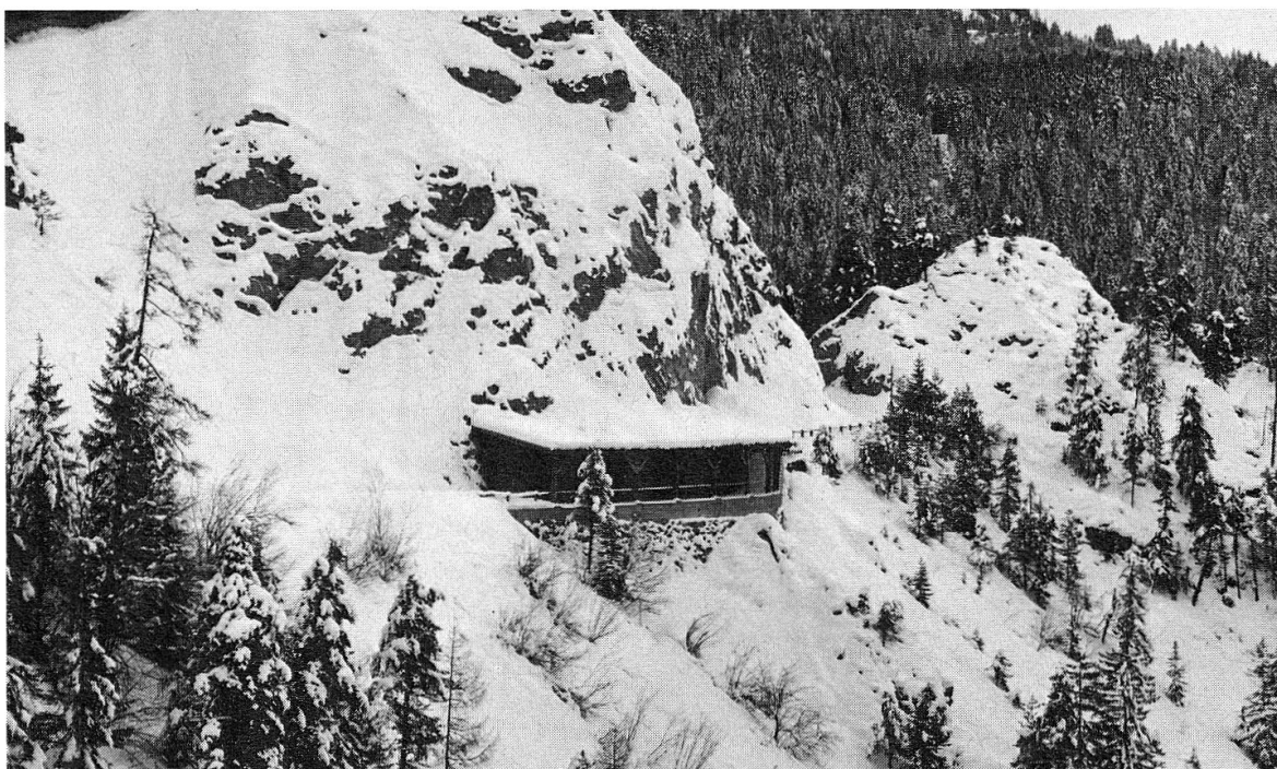
Lavinen- und Steinschlag-Galerie aus Holz. Heute führt hier die Strasse durch den Spitzg Tunnel. Die Galerie ist nicht mehr vorhanden.
