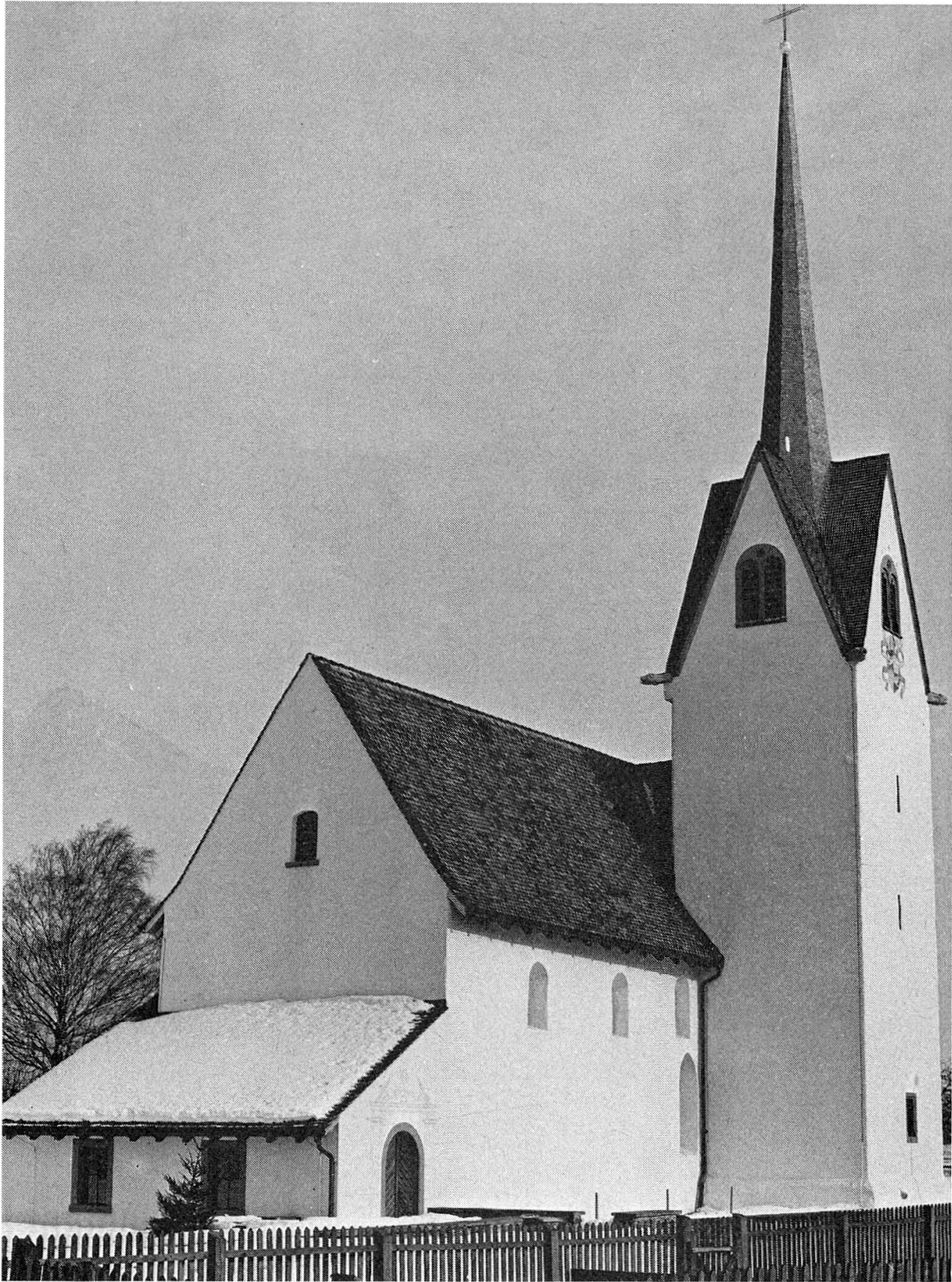
Abb. 1. Aussenansicht der Kapelle nach der letzten, 1981 abgeschlossenen Restaurierung. Blick von Südwesten, Richtung Bündner Herrschaft.
