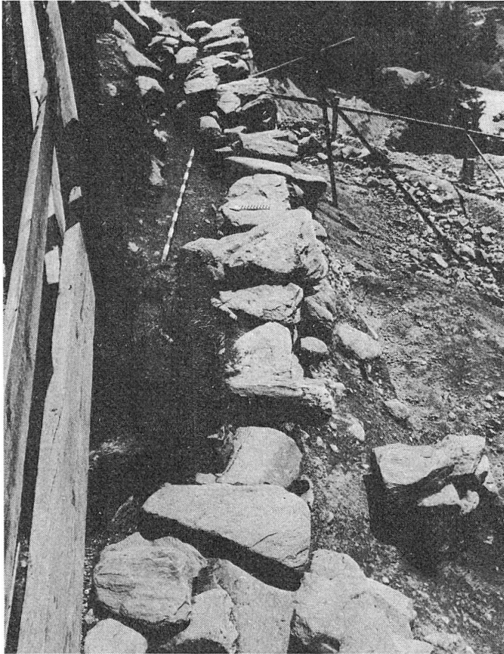
Abb. 15: Scharans, Spundas 1978; Süderweiterung der Felder 1 und 2, Mauer 1, Ansicht von West.
