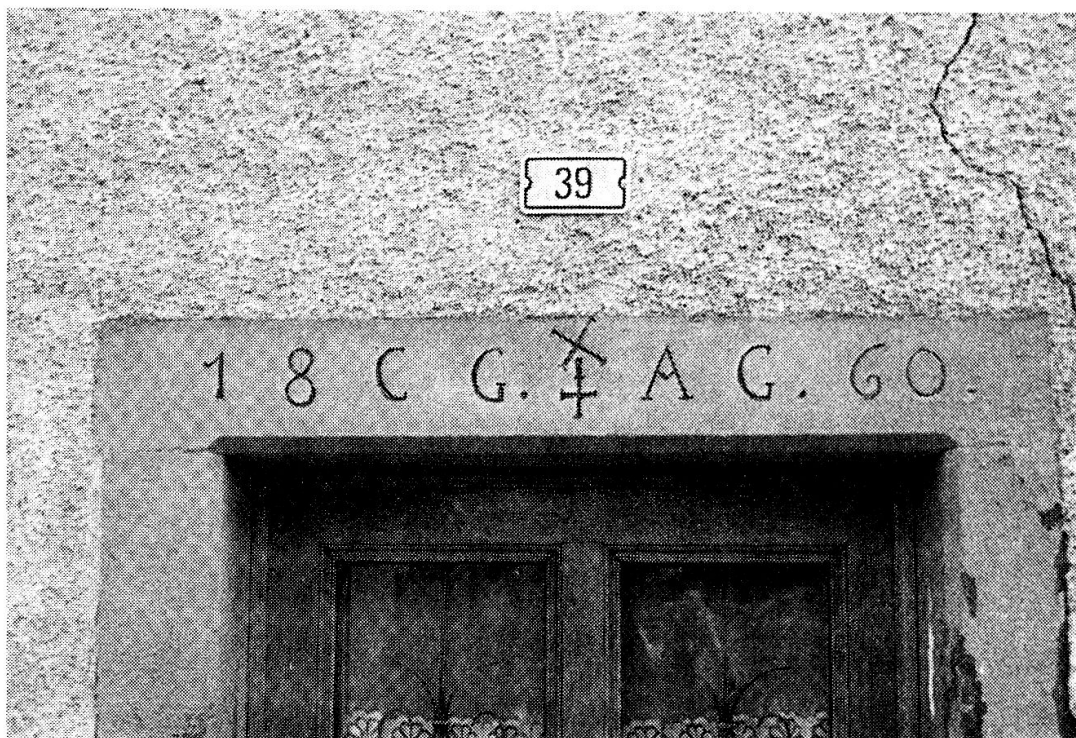
Abb. 2: Trimmis, Rheinstrasse; Beschrifteter Türsturz am Haus Nr. 39 in Trimmis.
