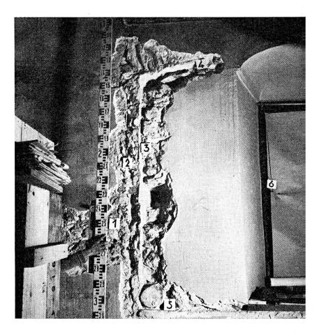
Bindesteine die beiden zu den grossen Tragsäulen reichenden Balken, auf denen die drei Tonnengewölbe abgestützt sind.
