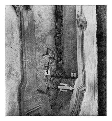
cm an der Ostmauer auf. Nach dem Entfernen des Verputzes zeigte sich, dass dieses Mauerwerk in der NO-Ecke der Kirche nicht mit der Nordmauer verbunden war.
