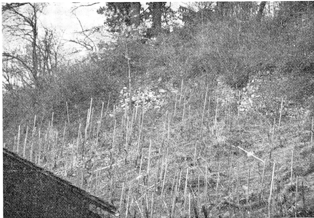
Die Reste der 100 Klafter langen Wingertmauer am «obern weingarten»
