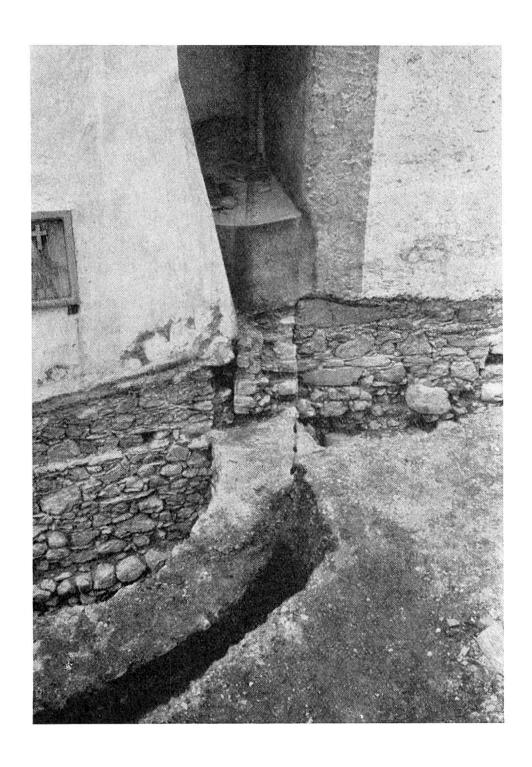
Abb. 14. Die Schiff-Nordwand geht verputzt hinter dem später angebauten Turm (rechts) durch.
