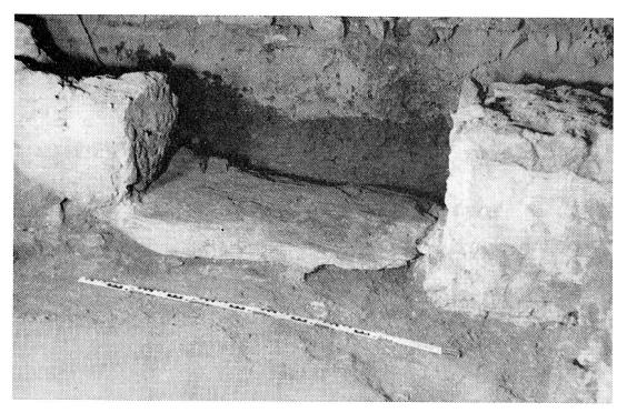
Abb. 12. Südeingang mit Schieferschwelle nach Entfernung der Vermauerung.
